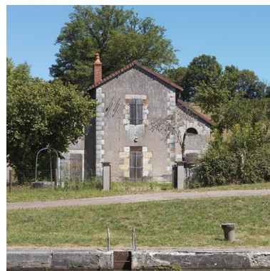
La maison éclusière de face.
