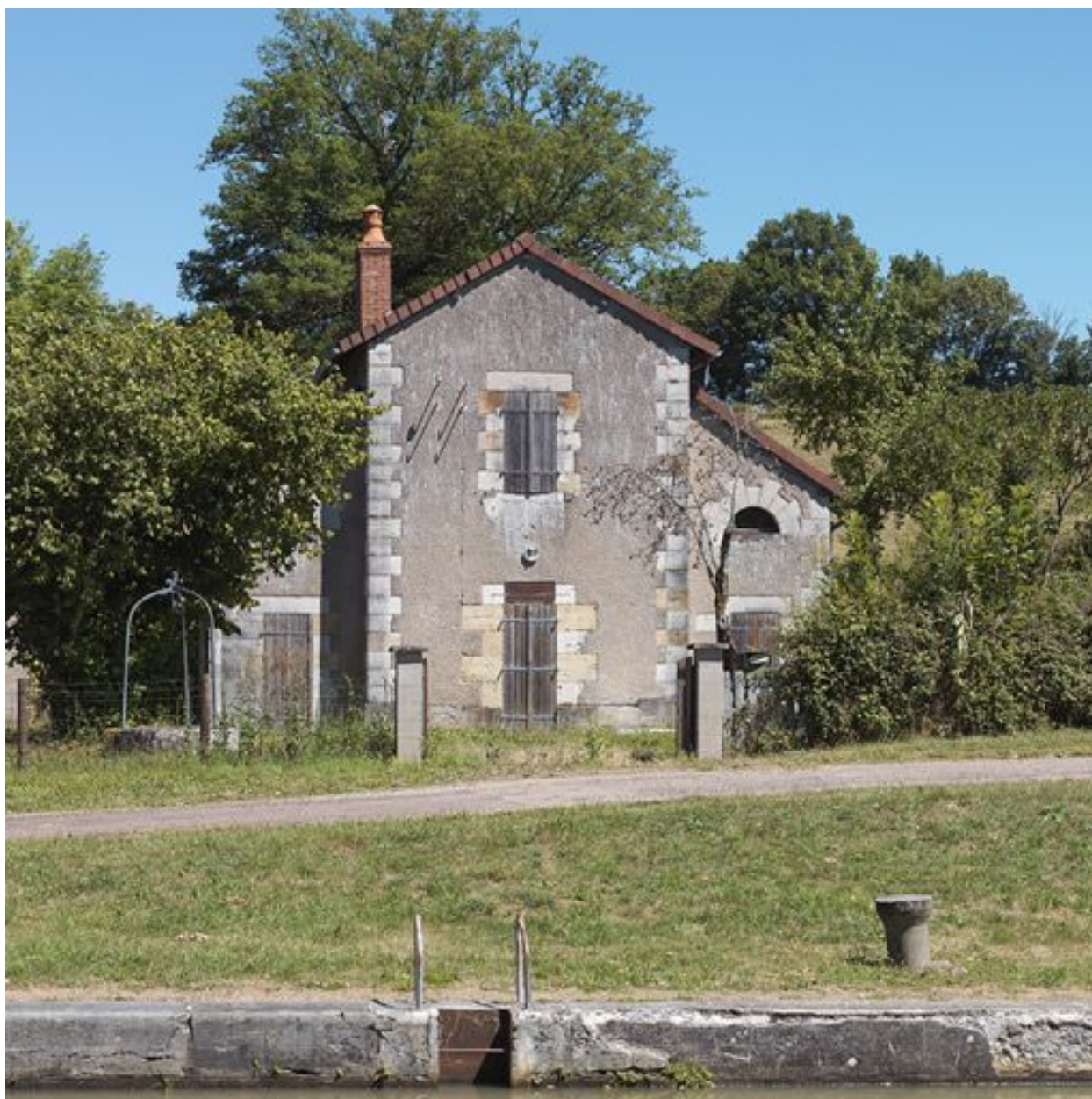
La maison éclusière de face.
