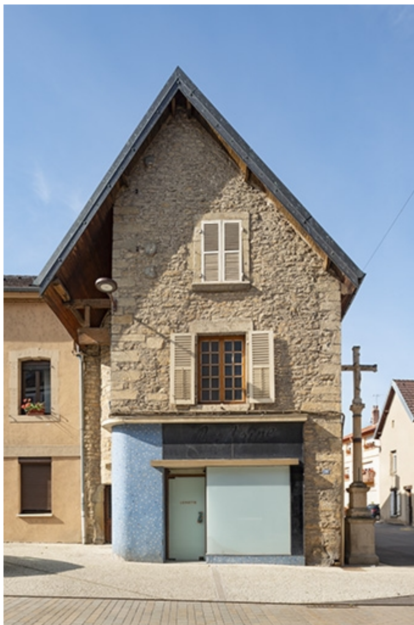
Le pignon depuis la rue Gambetta.
