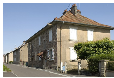
Enfilade de logements d'ouvriers (rue du Tissage). Phot. Jérôme Mongreville IVR43_20077000211NUCA
