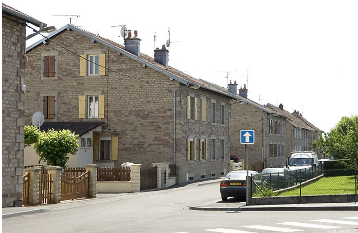
Logements d'ouvriers (rue du Tissage).
