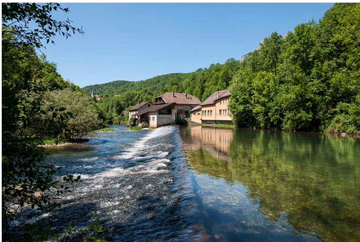
Vue d'ensemble depuis le barrage, en amont.
