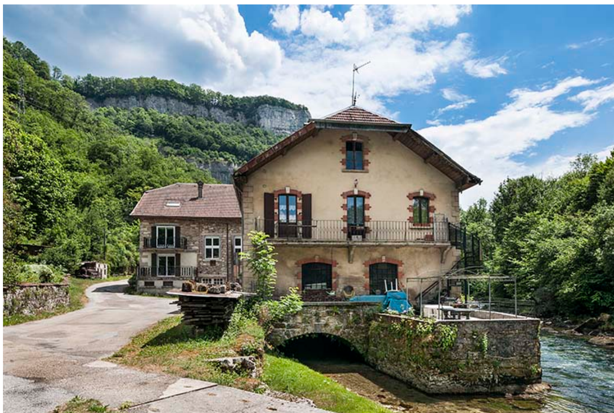
Vue rapprochée depuis l'ouest en 2015.
