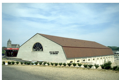
Vue d'ensemble du gymnase, depuis le sud-ouest. Phot. Laurent Poupard IVR43_19893900200ZA
