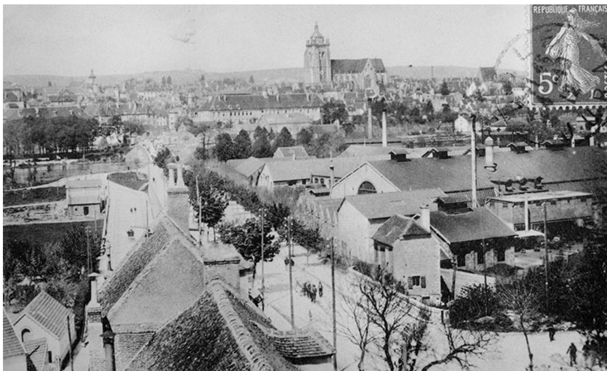
Dole. - Vue générale.
