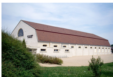
Façade latérale gauche du gymnase. Phot. Laurent Poupard IVR43_19893900201ZA
