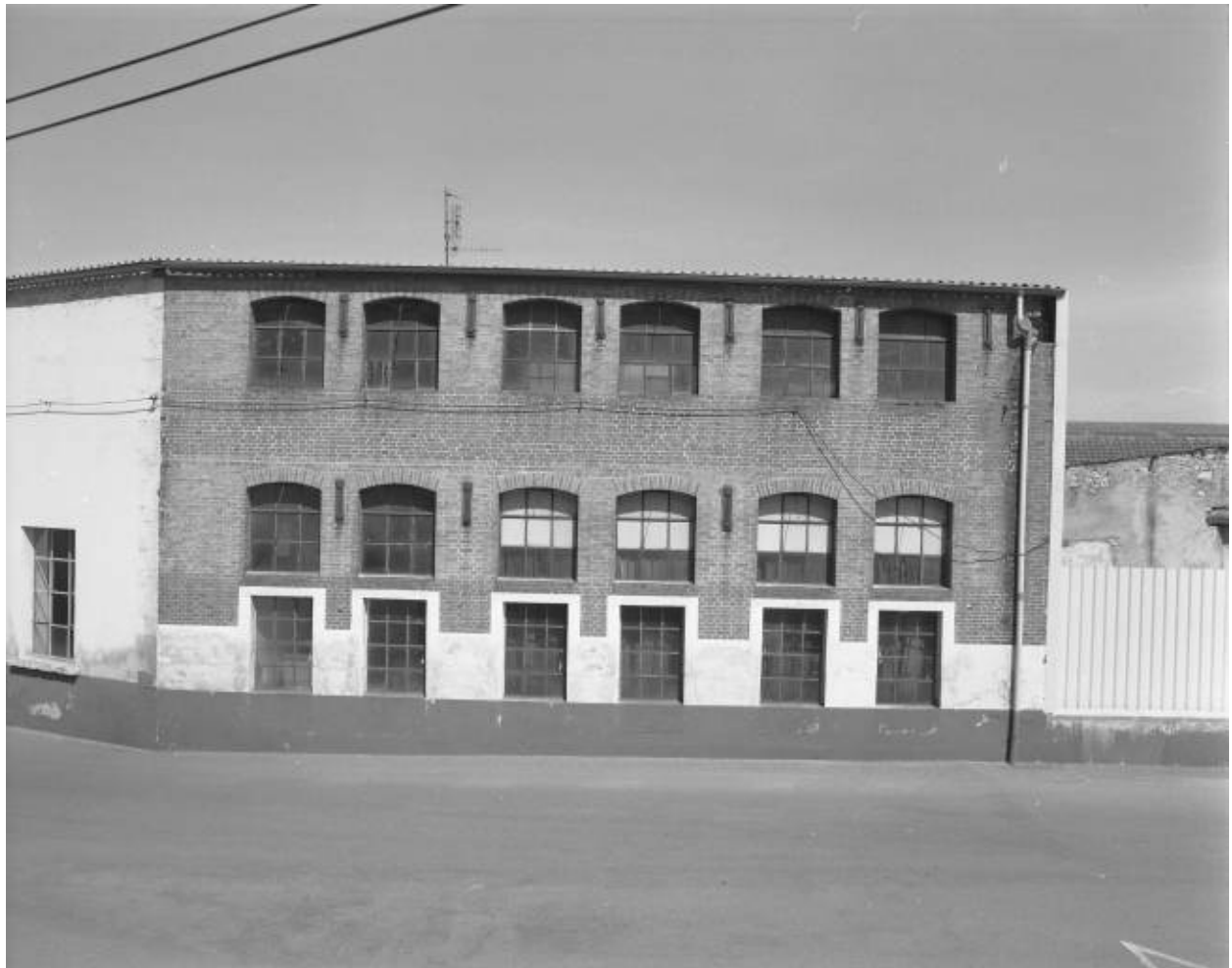
Atelier de contrôle. Vue de face.
