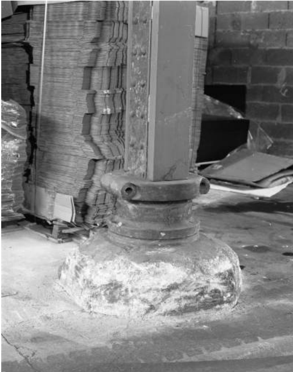
Ancienne fonderie. Base d'un pilier (fonte ?).
