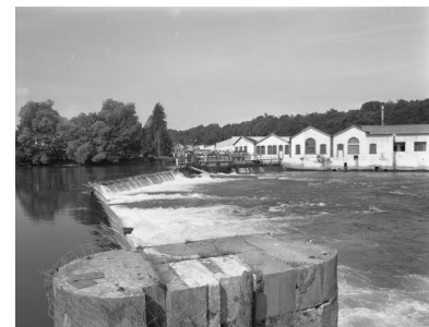
Vue d'ensemble depuis le pont. Photographie, s.d. [1914]. Phot. Jérôme Mongreville IVR43_20022500416X
