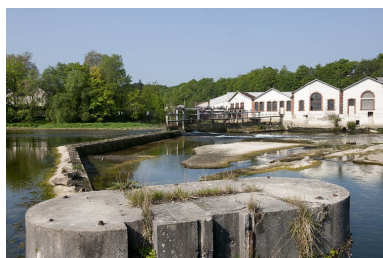
Le barrage depuis la rive droite. Phot. Jérôme Mongreville IVR43_20112501585NUC4A
