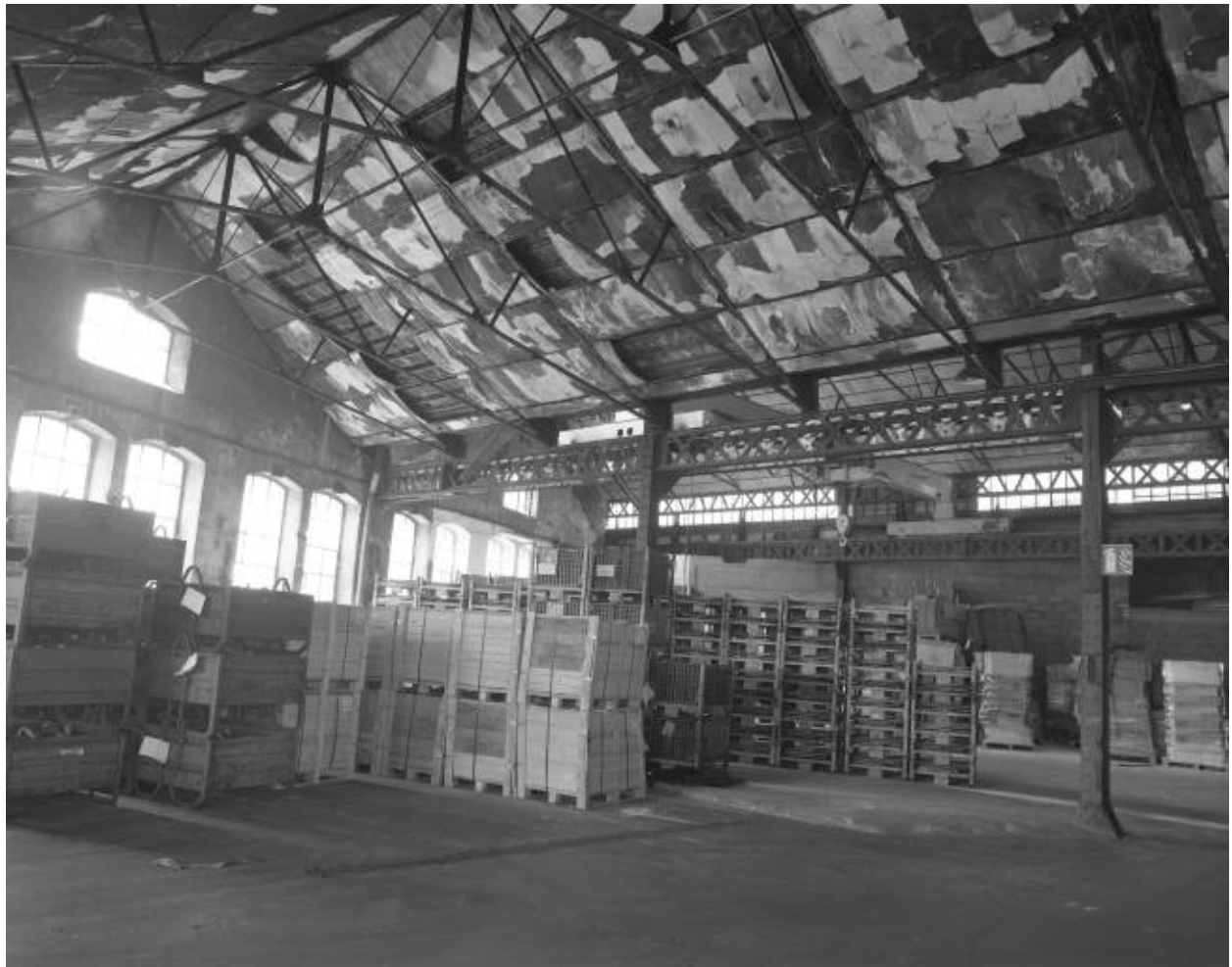
Ancienne fonderie. Vue intérieure générale.
