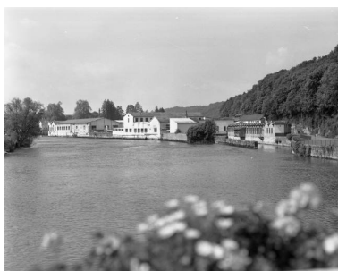
Bâtiment d'eau. Poulies de la charpente. Phot. Jérôme Mongreville IVR43_20022500419X
