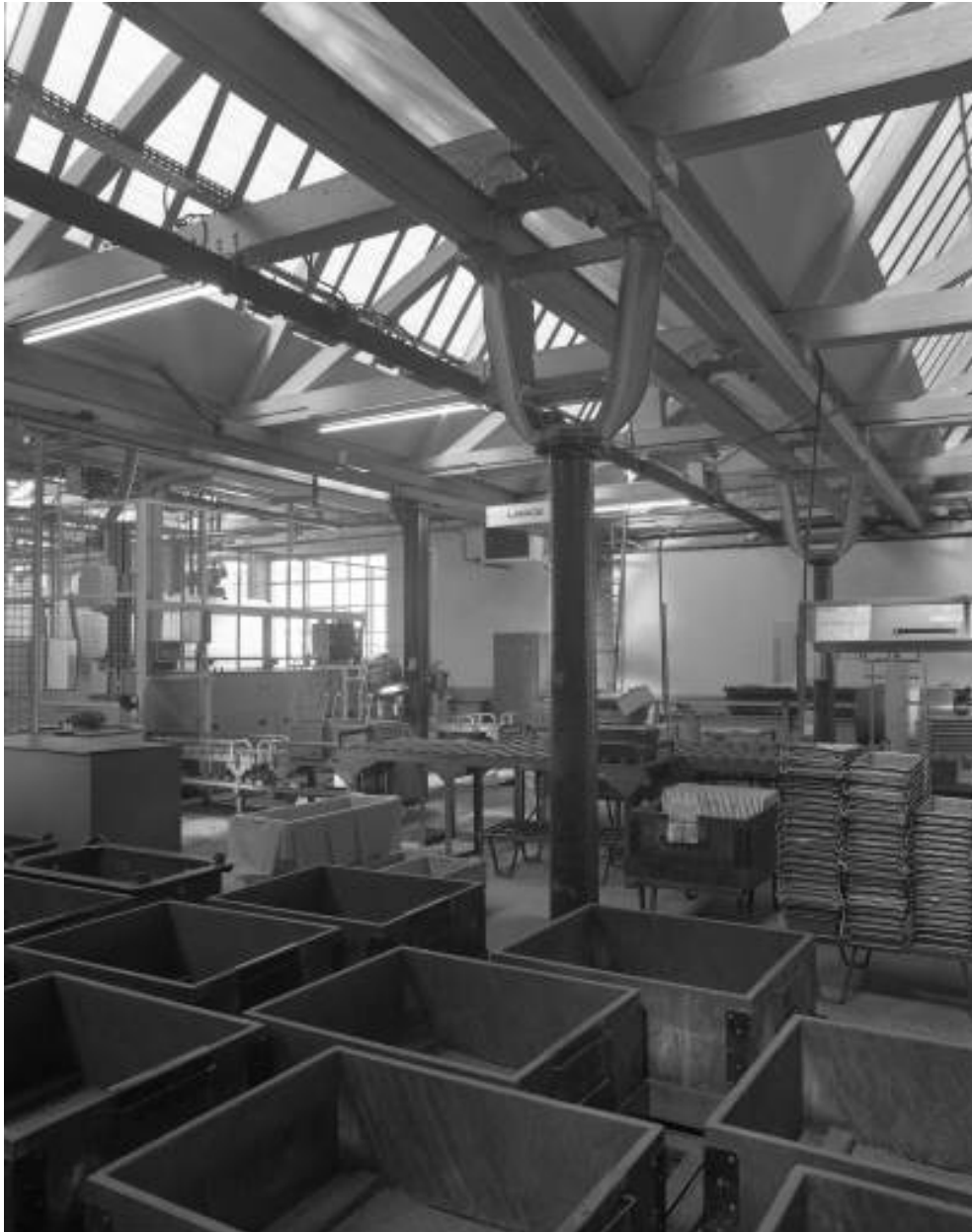
Atelier des culbuteurs. Charpente en bois.
