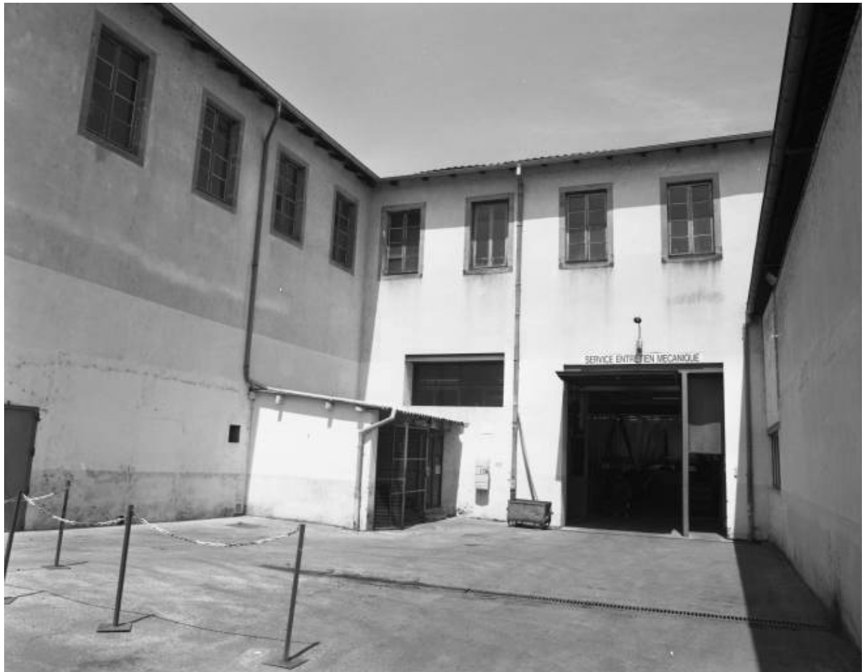
Atelier outillage-entretien mécanique. Façade sud.
