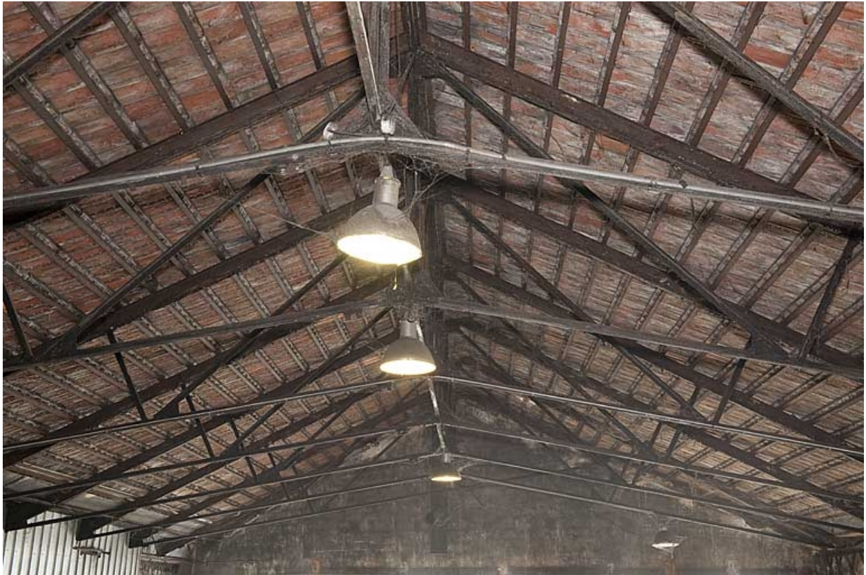
Charpente métallique d'un magasin industriel.
