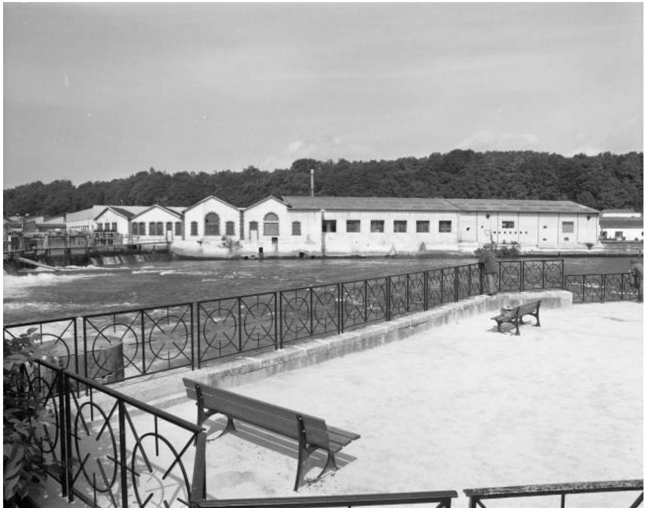
Bâtiments sud depuis la rive droite.
