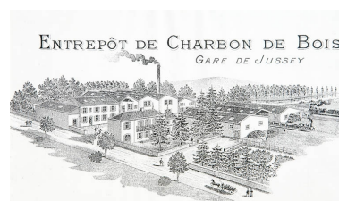
Entrepôt de charbon de bois [vue cavalière]. Phot. Jérôme Mongreville IVR43_20097000747NUC2A
