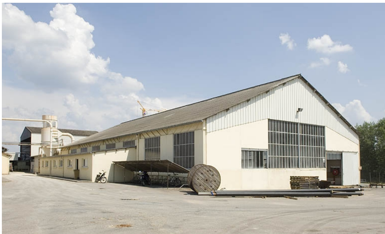
Atelier de fabrication (moulures).
