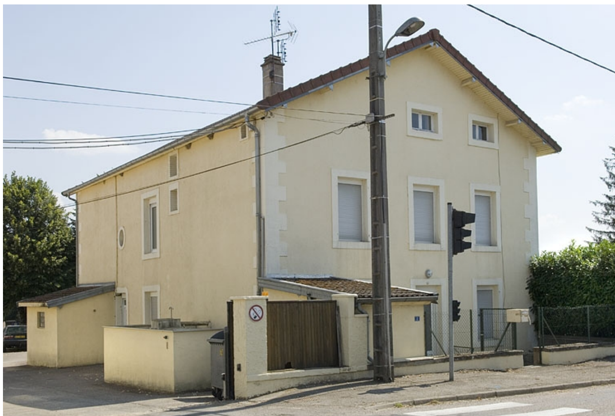
Logement (ancien bureau).
