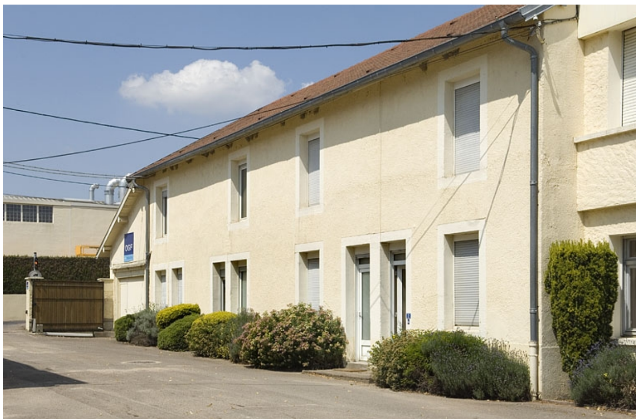
Façade ouest des logements.
