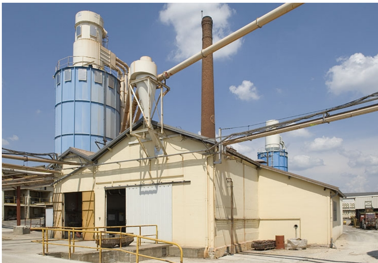
Salle des machines et chaufferie.
