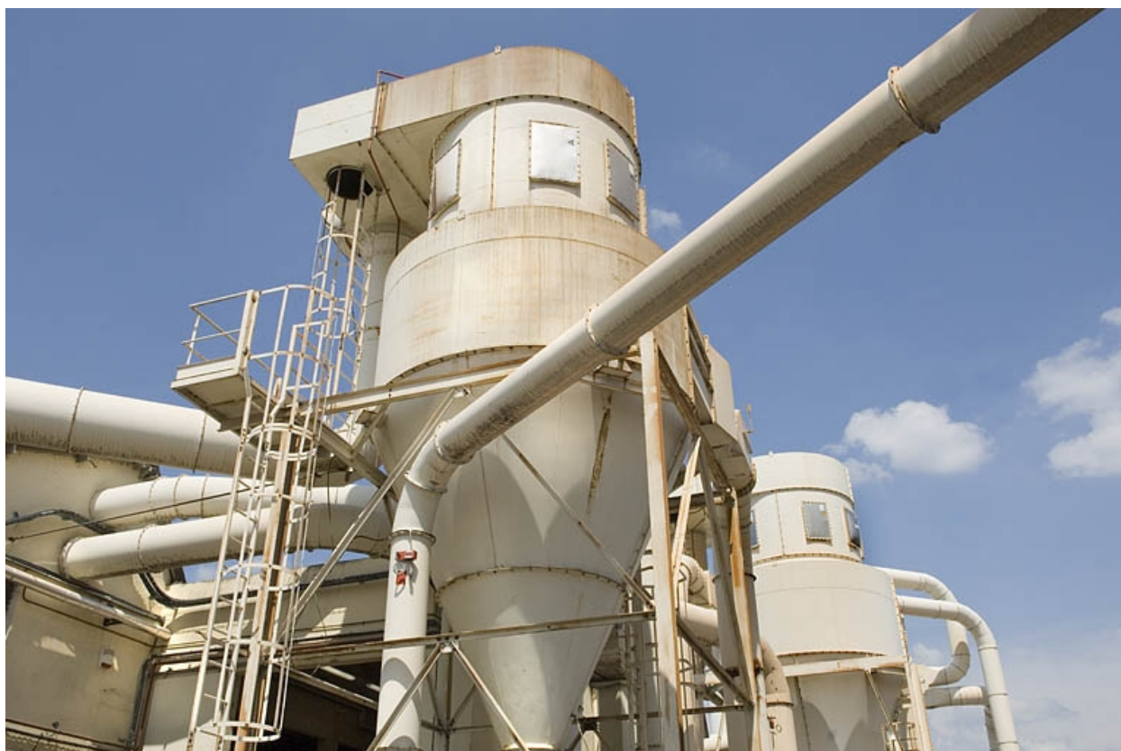
Silos de sciure.
