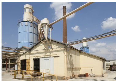
Salle des machines et chaufferie. Phot. Jérôme Mongreville IVR43_20097000751NUC2A
