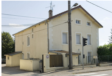
Logement (ancien bureau). Phot. Jérôme Mongreville IVR43_20097000761NUC2A
