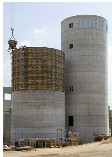
Chaufferie et silos à sciure en construction. Phot. Jérôme Mongreville IVR43_20097000760NUC2A
