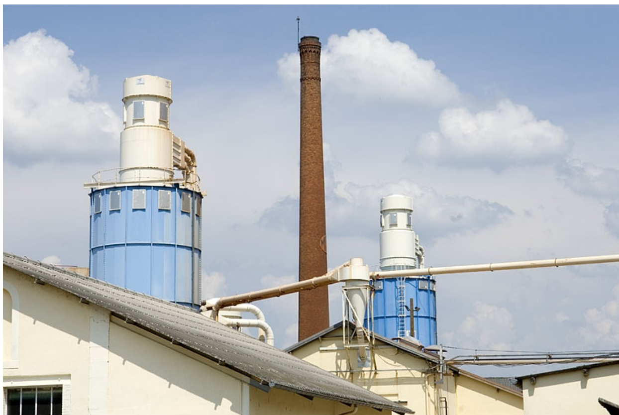
Silos et cheminée depuis le sud-ouest.
