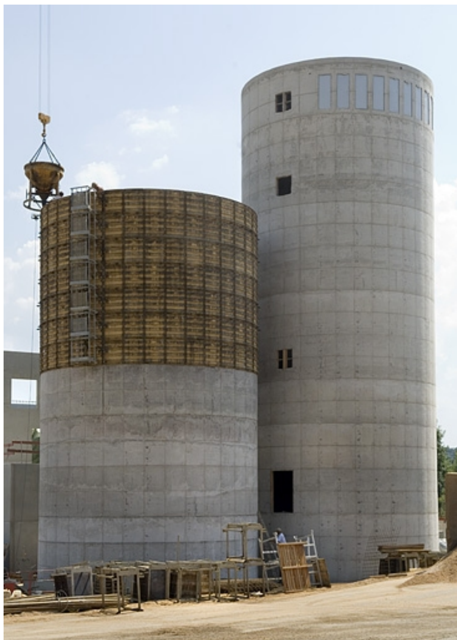
Chaufferie et silos à sciure en construction.
