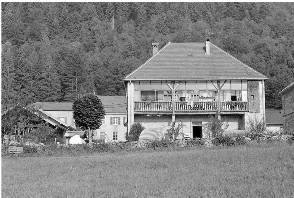
Vue générale de la façade postérieure.
