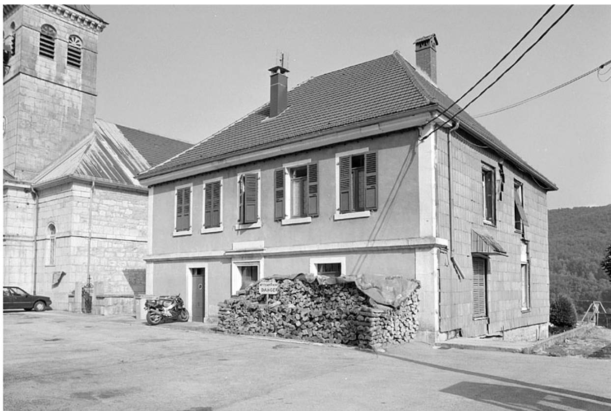
Vue générale depuis la place de l'Eglise.
