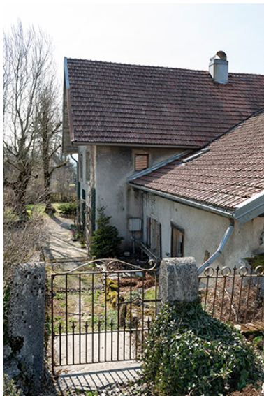
Accès depuis la rue. Phot. Sonia Dourlot IVR43_20192500323NUC4A
