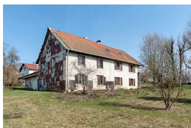
Façades ouest et sud. Phot. Sonia Dourlot IVR43_20192500325NUC4A
