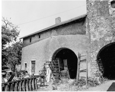
Façade antérieure : partie gauche. Phot. Dominique Humbert IVR43_19767000477X
