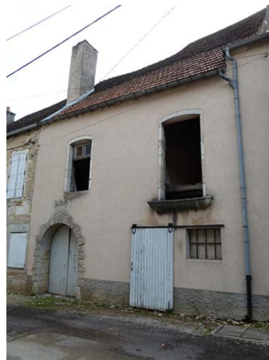
Partie est de la construction Phot. Sabrina Dalibard IVR43_20137000806NUC2A
