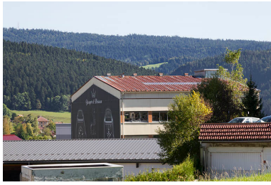
Corps nord : façades postérieure et latérale droite. Phot. Yves Sancey IVR43_20132502169NUC2A
