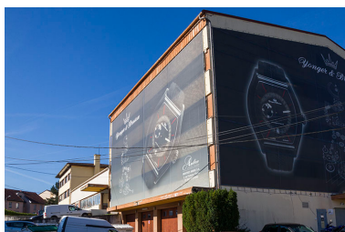
Corps nord : façades antérieure et latérale droite. Phot. Yves Sancey IVR43_20132502175NUC2A
