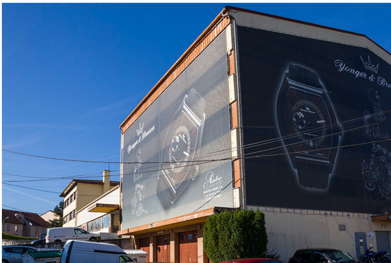
Corps nord : façades antérieure et latérale droite.
