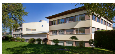
Vue d'ensemble, depuis le sud- ouest (façade postérieure). Phot. Yves Sancey IVR43_20132502172NUC2A
