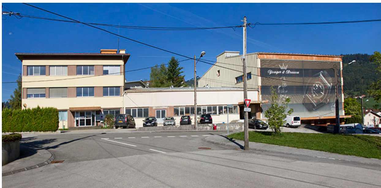
Vue d'ensemble, depuis l'est (façade antérieure).
