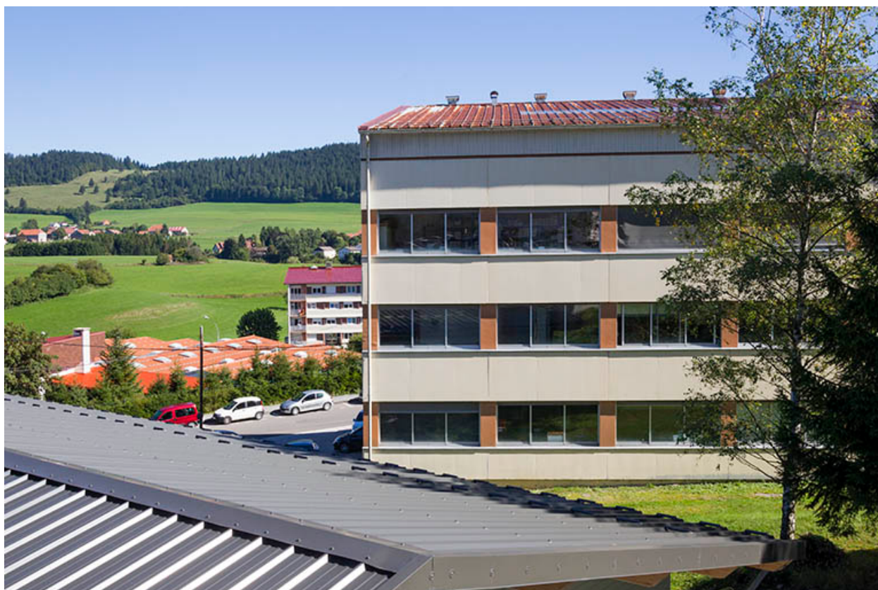
Corps nord : façade postérieure.
