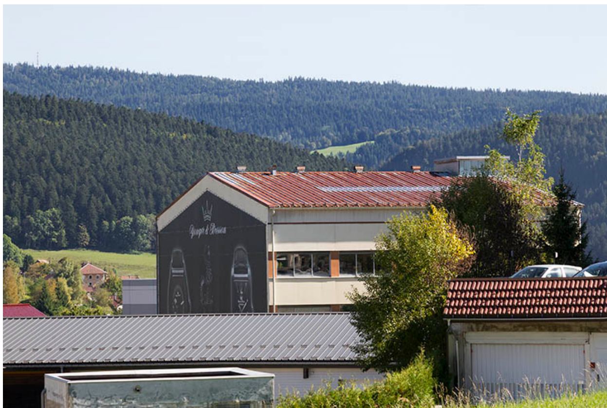
Corps nord : façades postérieure et latérale droite.
