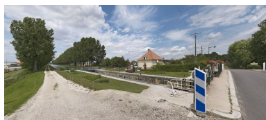
Vue d'aval. Phot. Thierry Kuntz IVR26_20112103098NUC4A
