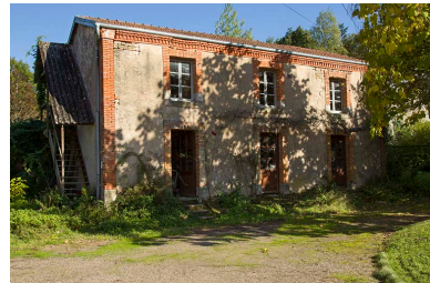
La maison d'ouvriers. Phot. Sonia Dourlot IVR43_20157000689NUC2A
