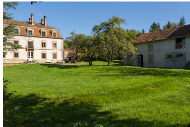
Vue générale. Phot. Sonia Dourlot IVR43_20157000687NUC2A
