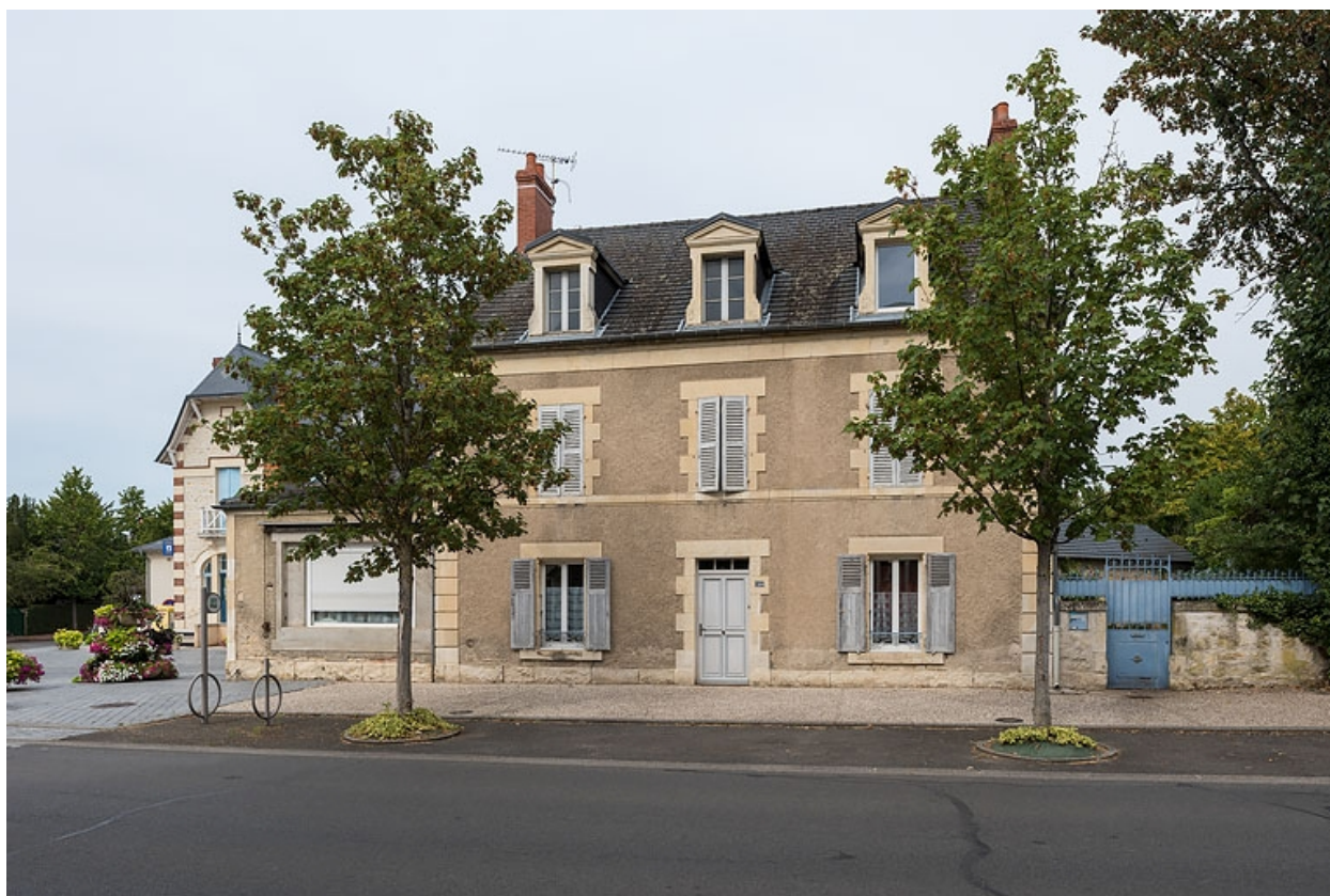
Façade sur l'avenue de Paris.
