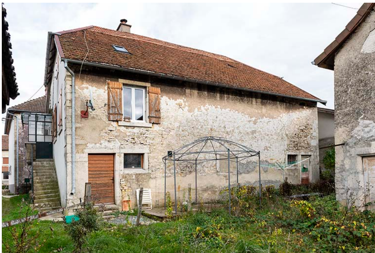
Grange : façade postérieure.
