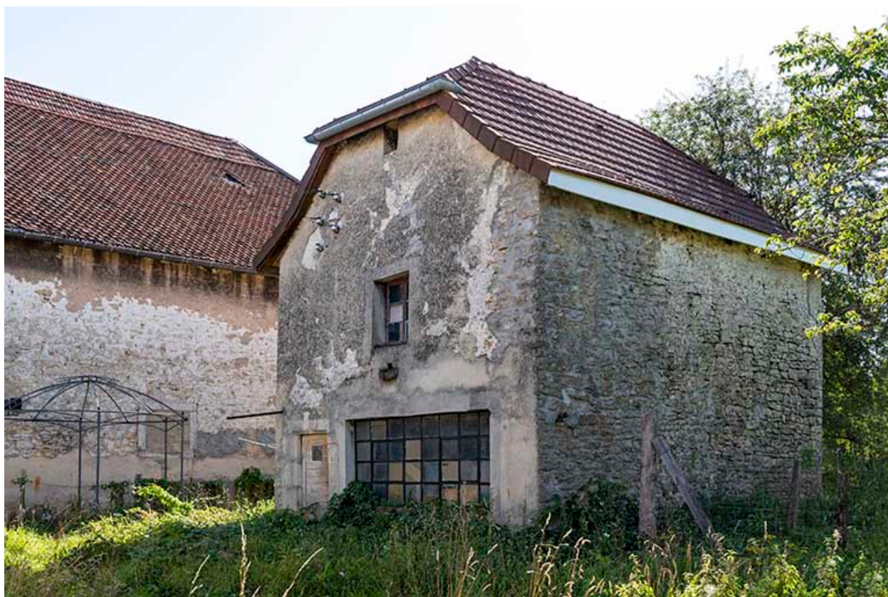
Forge : façades antérieure et latérale droite.
