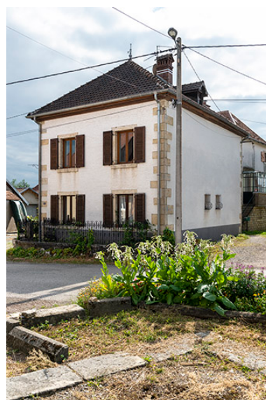
Maison de 1853, de trois quarts droite. Phot. Sonia Dourlot IVR43_20192501295NUC4A
