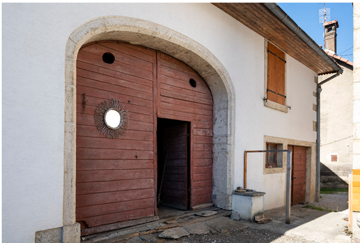
Grange : façade antérieure, de trois quarts gauche.
