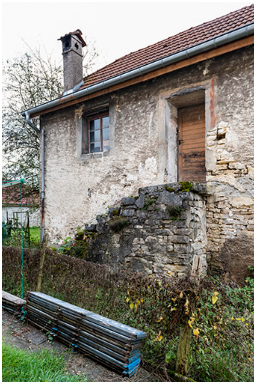
Forge : façade latérale gauche.
