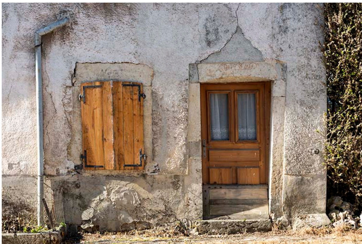
Maison de 1786, façade antérieure : porte et fenêtre.
