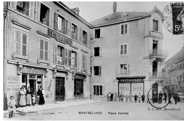
Montbéliard. Place Velotte, entre 1904 et 1908. Phot. Jérôme Mongreville IVR43_19862500464V
