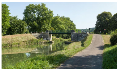
Vue d'aval du pont. Phot. Pierre-Marie Barbe-Richaud IVR26_20138900143NUC4AQ
