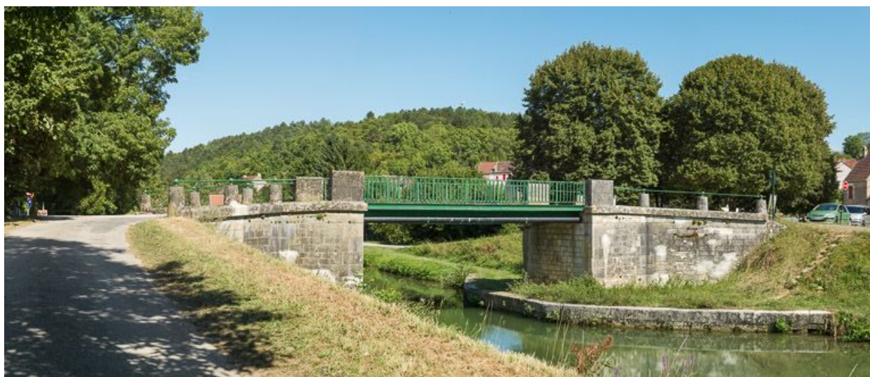
Vue d'amont du pont.
