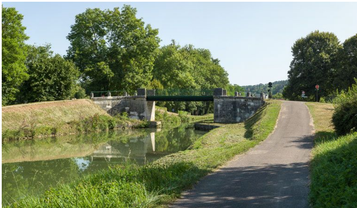
Vue d'aval du pont.
