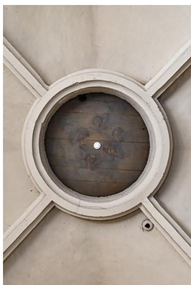
Tour sud, rez-de-chaussée (loge d'acteur côté cour) : ouverture zénithale, avec couvercle peint. Phot. Pierre-Marie Barbe-Richaud IVR26_20222100468NUC4A
