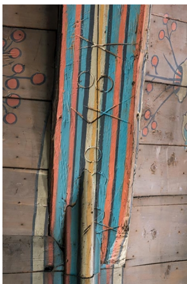
Nef, charpente lambrissée : marques de charpentier à la retombée, vers la croisée du transept. Phot. Pierre-Marie Barbe-Richaud IVR26_20222100435NUC4A
