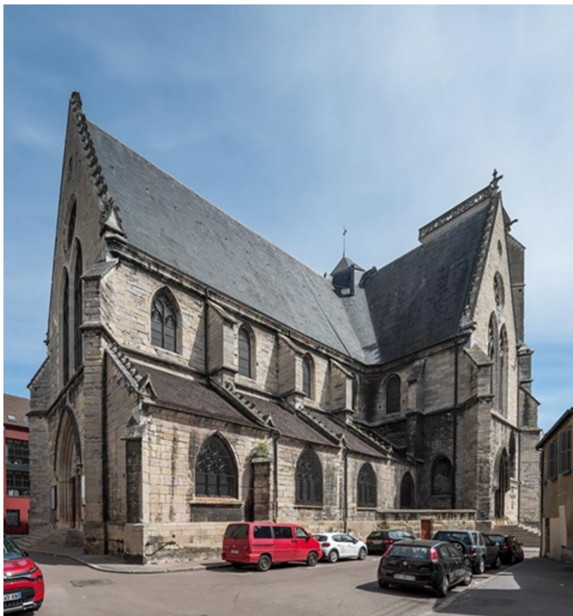
Façade sud, de trois quarts gauche.
