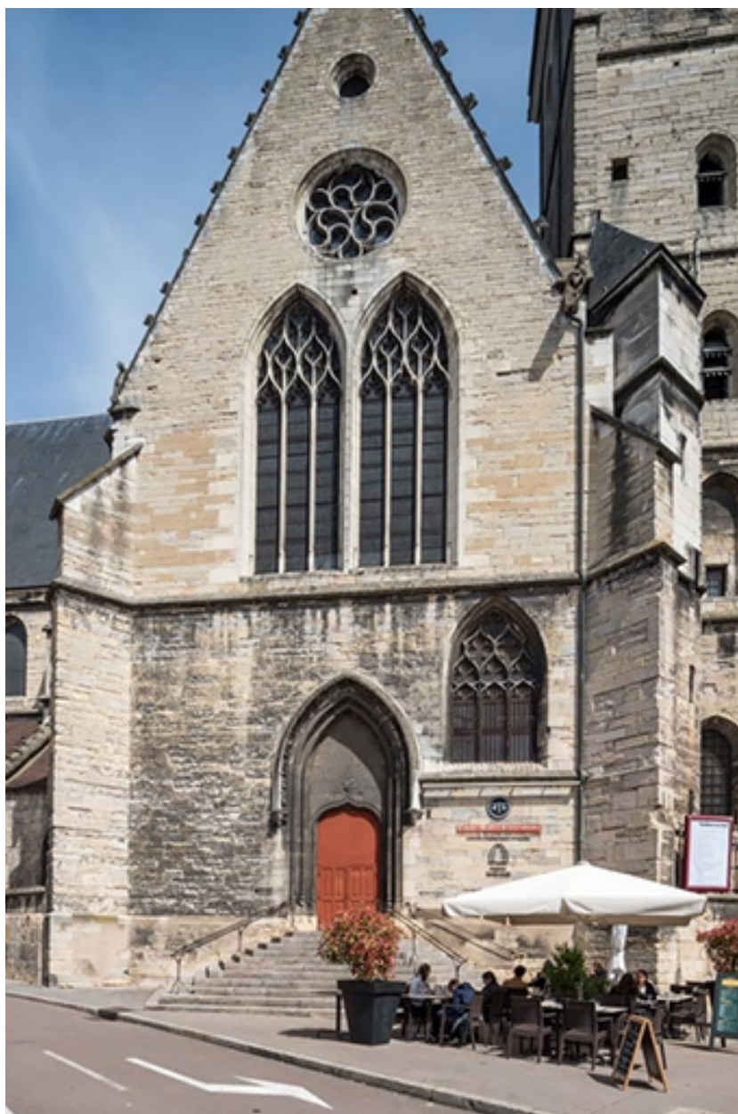
Façade sud : extrémité du transept.
