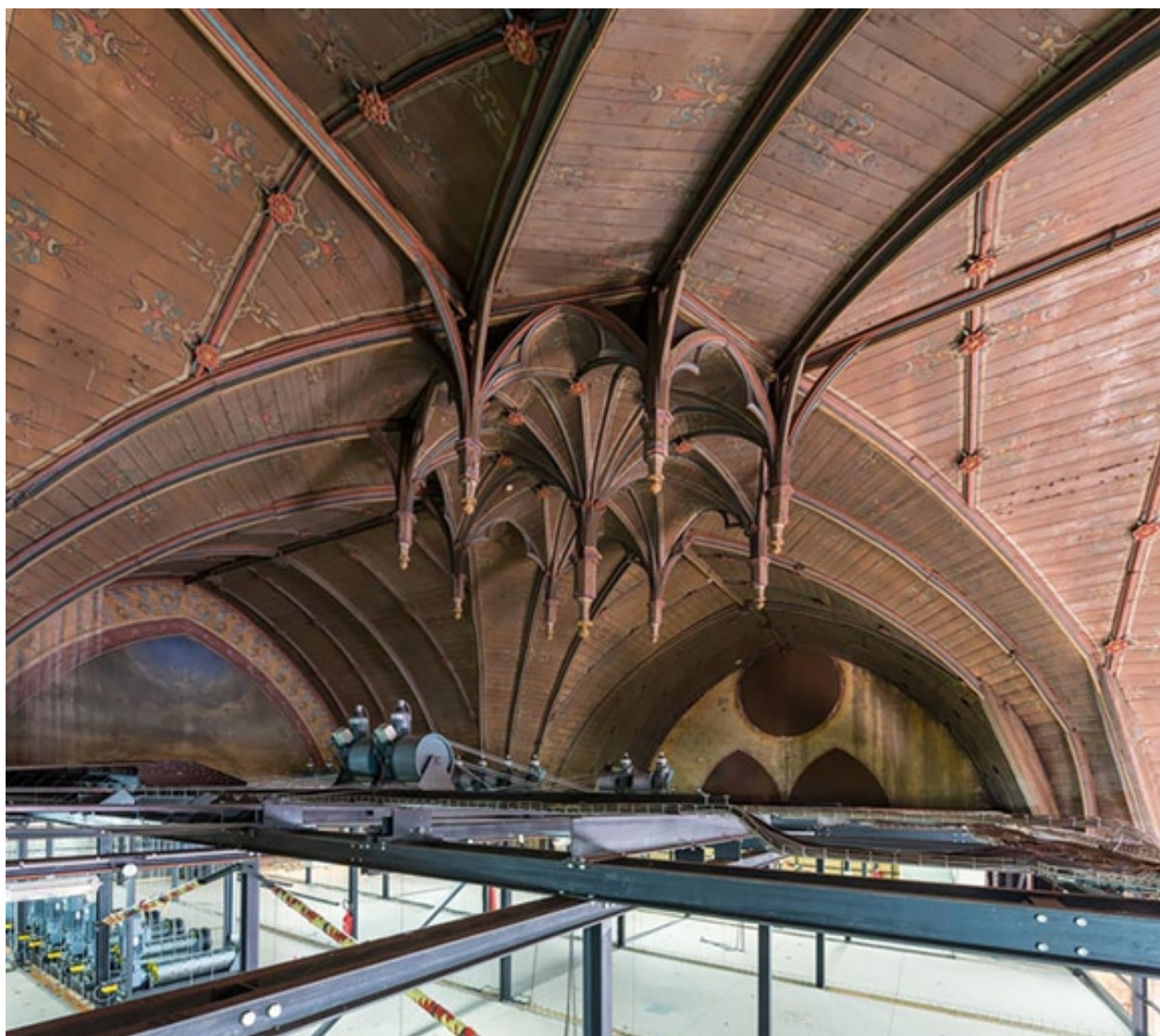
Croisée du transept : charpente lambrissée.
