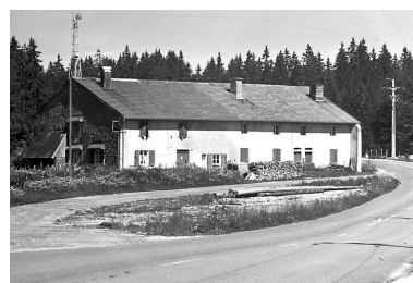
Ferme située au lieudit Joux Dessus.
