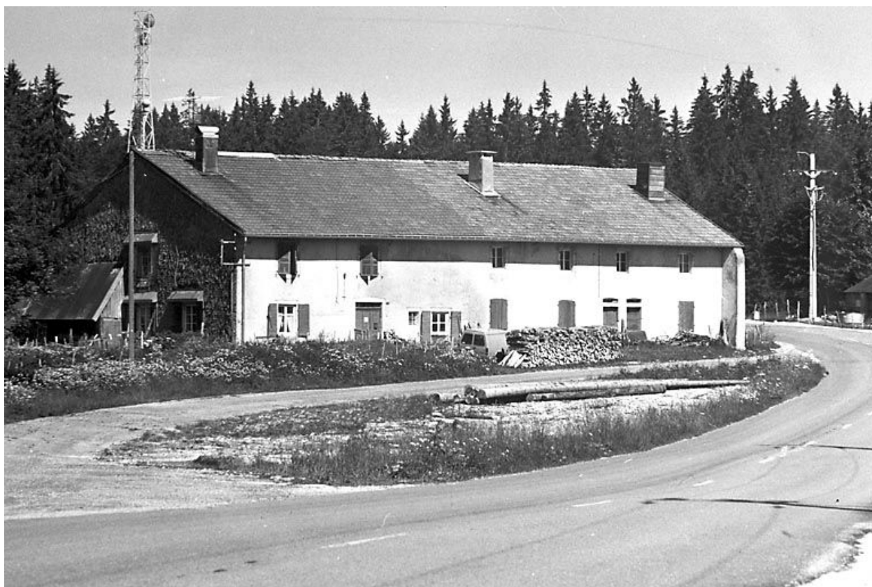
Ferme située au lieudit Joux Dessus.
