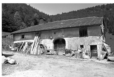
Ferme située au lieudit Près des Arcets.
