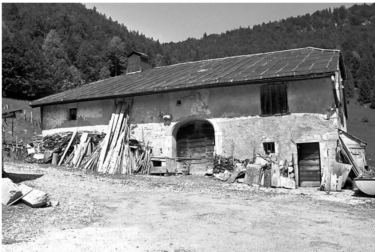
Ferme située au lieudit Près des Arcets.
