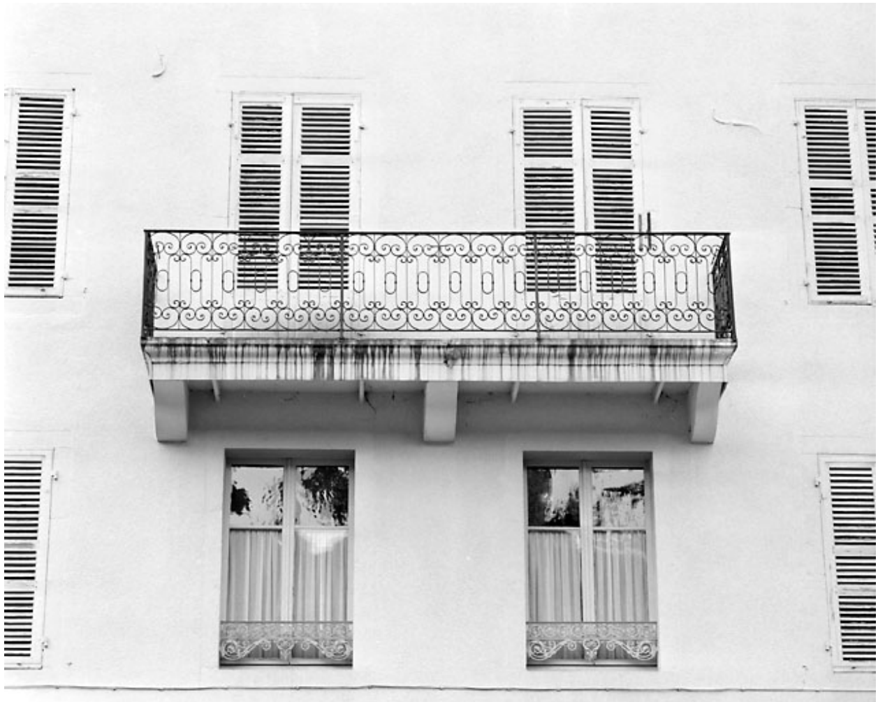
Façade postérieure : balcon.
