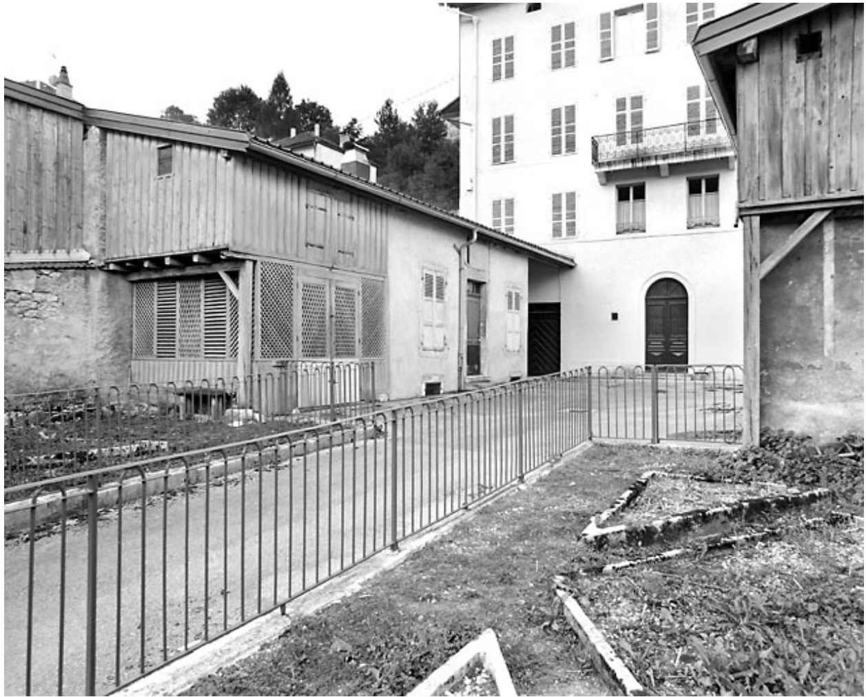
Jardin, cour et bâtiment sud.
