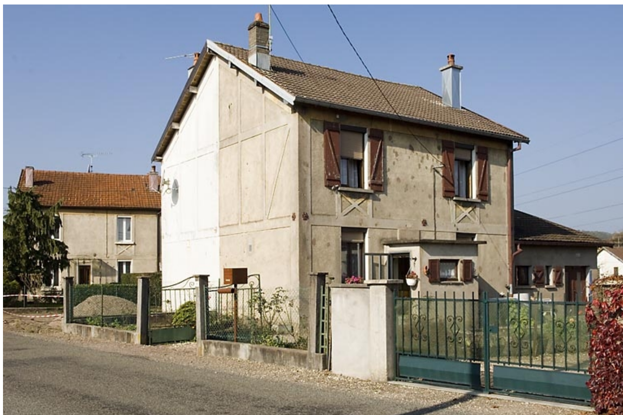
Maisons doubles à étage.
