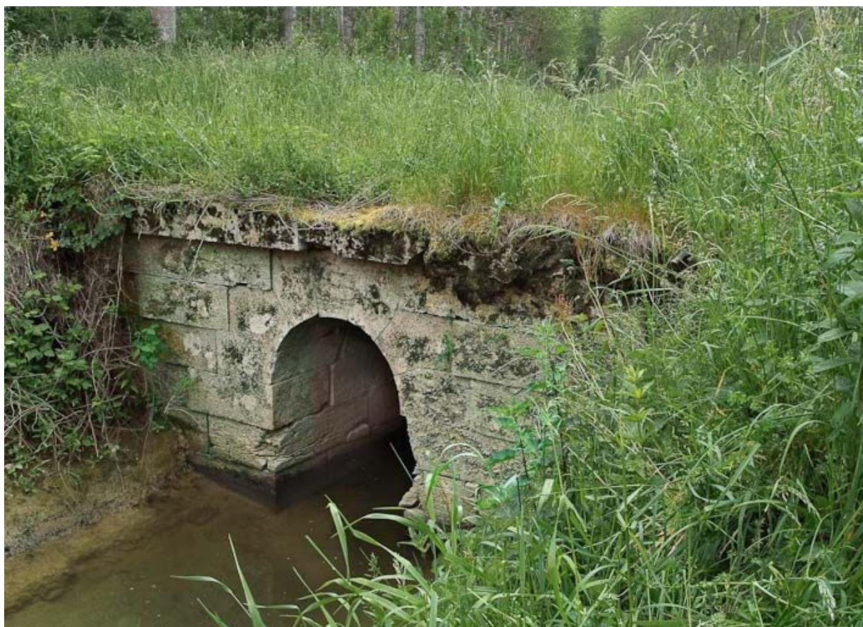
Ponceau, vue rapprochée.
