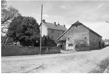
Ferme dissociée avec cour fermée. Phot. Bernard Lardière IVR43_19817000338Z
