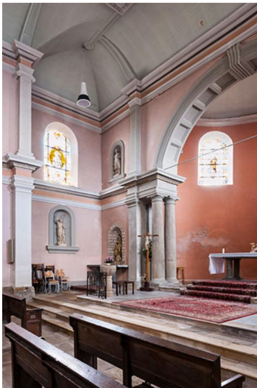
Jonction entre le mur collatéral Ouest et le chœur: retombée de voute sur deux colonnes doubles.
