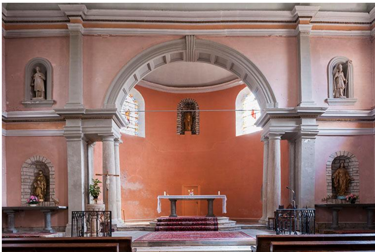
Choeur de l'église, arc en plein cintre retombant sur deux paires de colonnes doubles.
