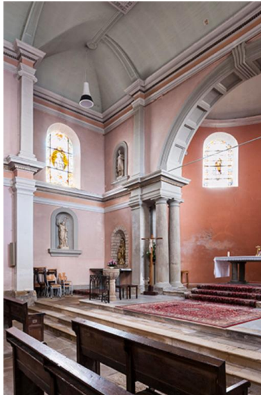
Jonction entre le mur collatéral Ouest et le chœur: retombée de voute sur deux colonnes doubles. Phot. Jérôme Mongreville IVR43_20167001338NUC4A
