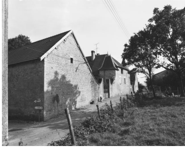
Elévation sur la rue. Phot. Dominique Dominguez IVR43_19803900042X
