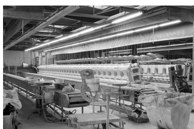
Atelier de coulage D (9), intérieur. Phot. Laurent Poupard IVR43_19893901135Z
