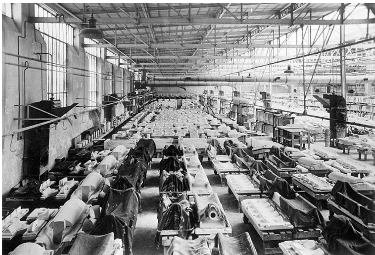
Atelier de coulage.
