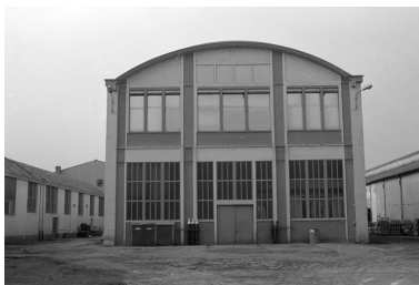
Atelier de réparation (5). Phot. Laurent Poupard IVR43_19893901127Z
