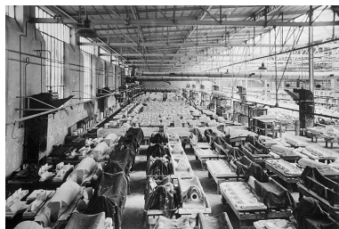
Atelier de coulage. Phot. Laurent Poupard, Autr. A. Bignon IVR43_19893900289Z
