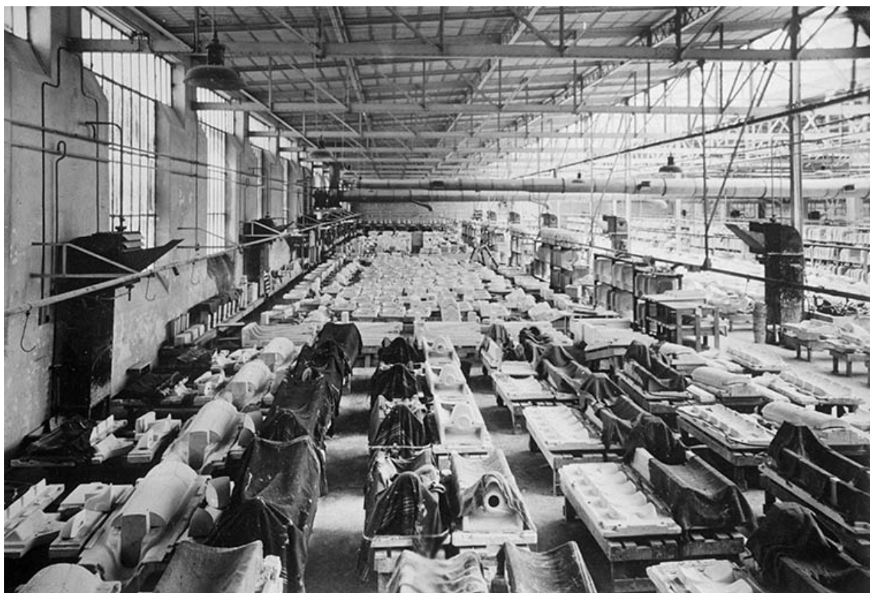
Atelier de coulage.
