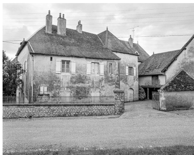
Demeure située rue de l'Eglise. Phot. Dominique Dominguez IVR43_19807000415X
