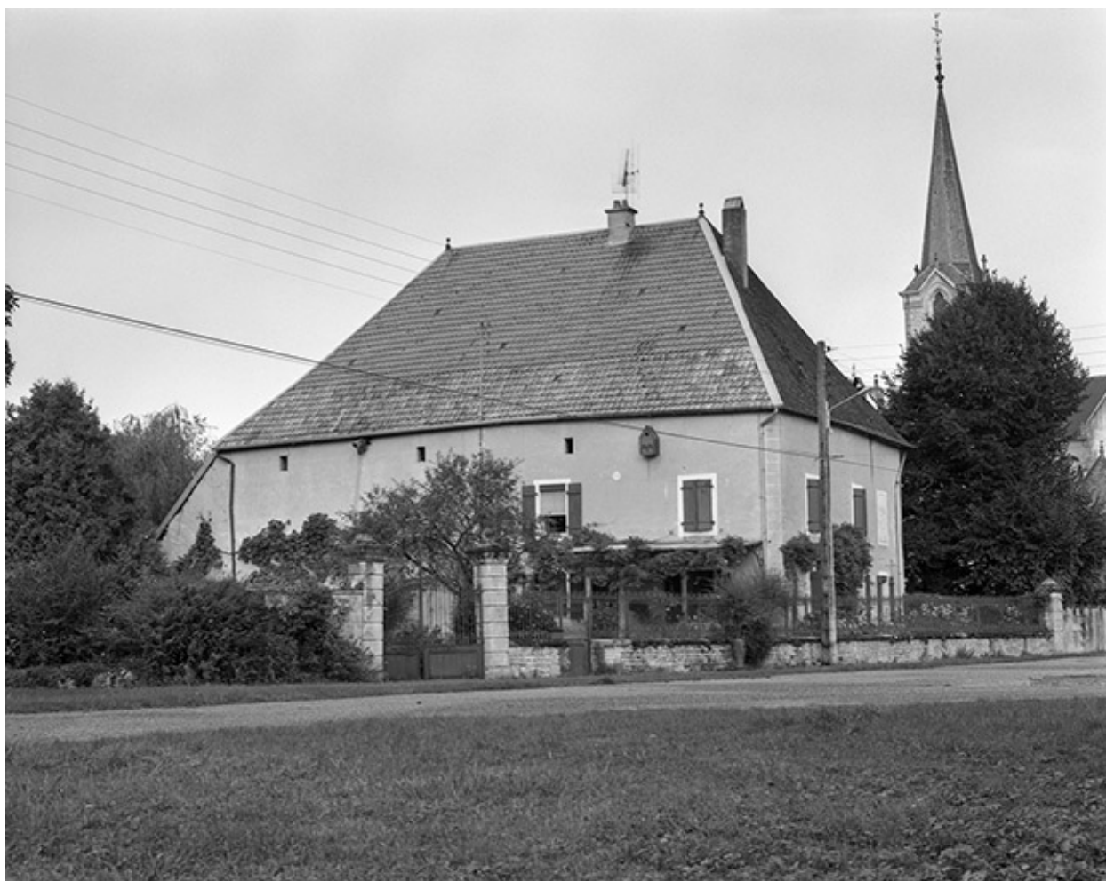
Ferme située route Vers le lavoir.
