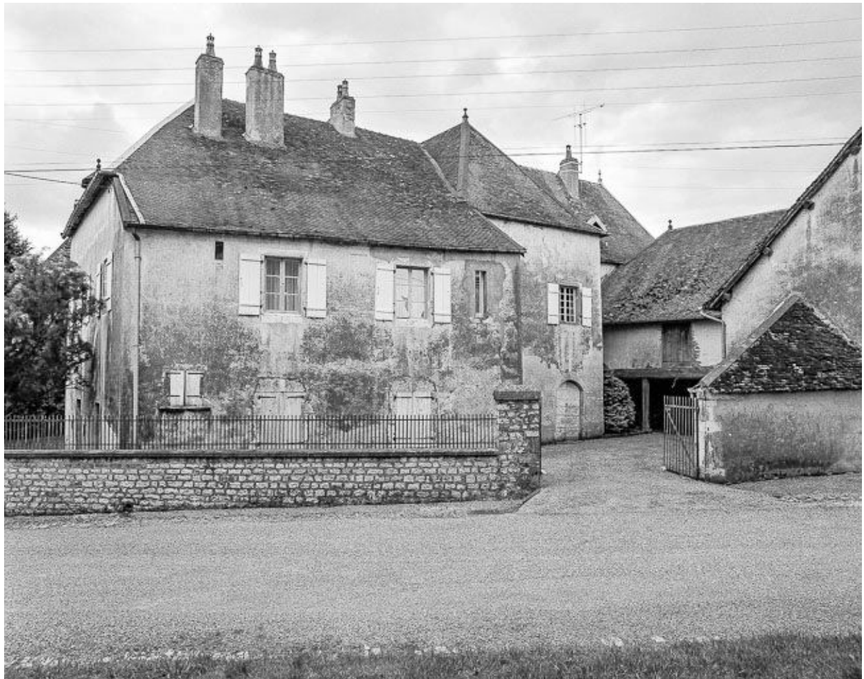
Demeure située rue de l'Eglise.
