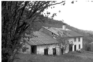
Façade antérieure vue de trois quarts. Phot. Jérôme Mongreville IVR43_20013900506X
