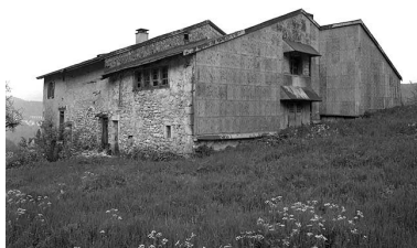
Face gauche et façade postérieure. Phot. Jérôme Mongreville IVR43_20013900504X
