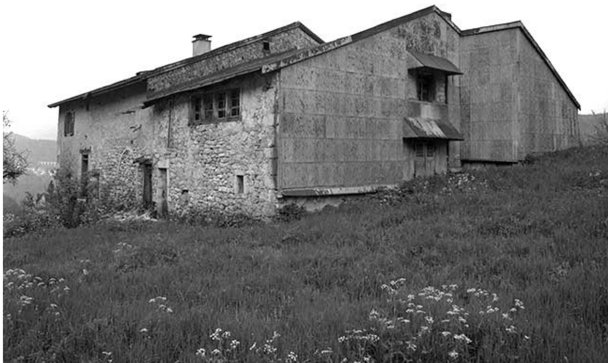
Face gauche et façade postérieure.
