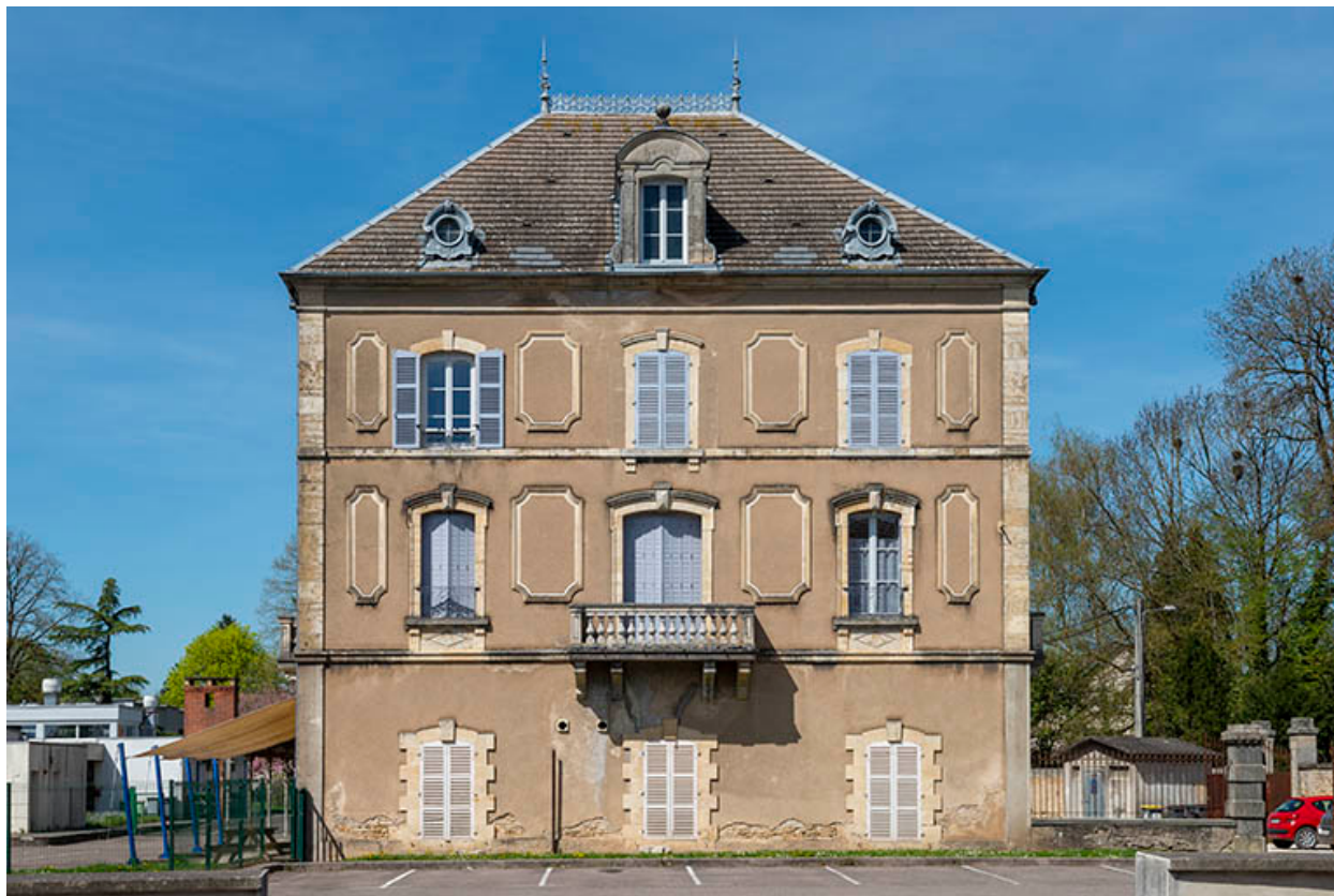
Corps de bâtiment sud, vue de face.
