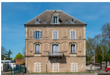
Corps de bâtiment sud, vue de face.
