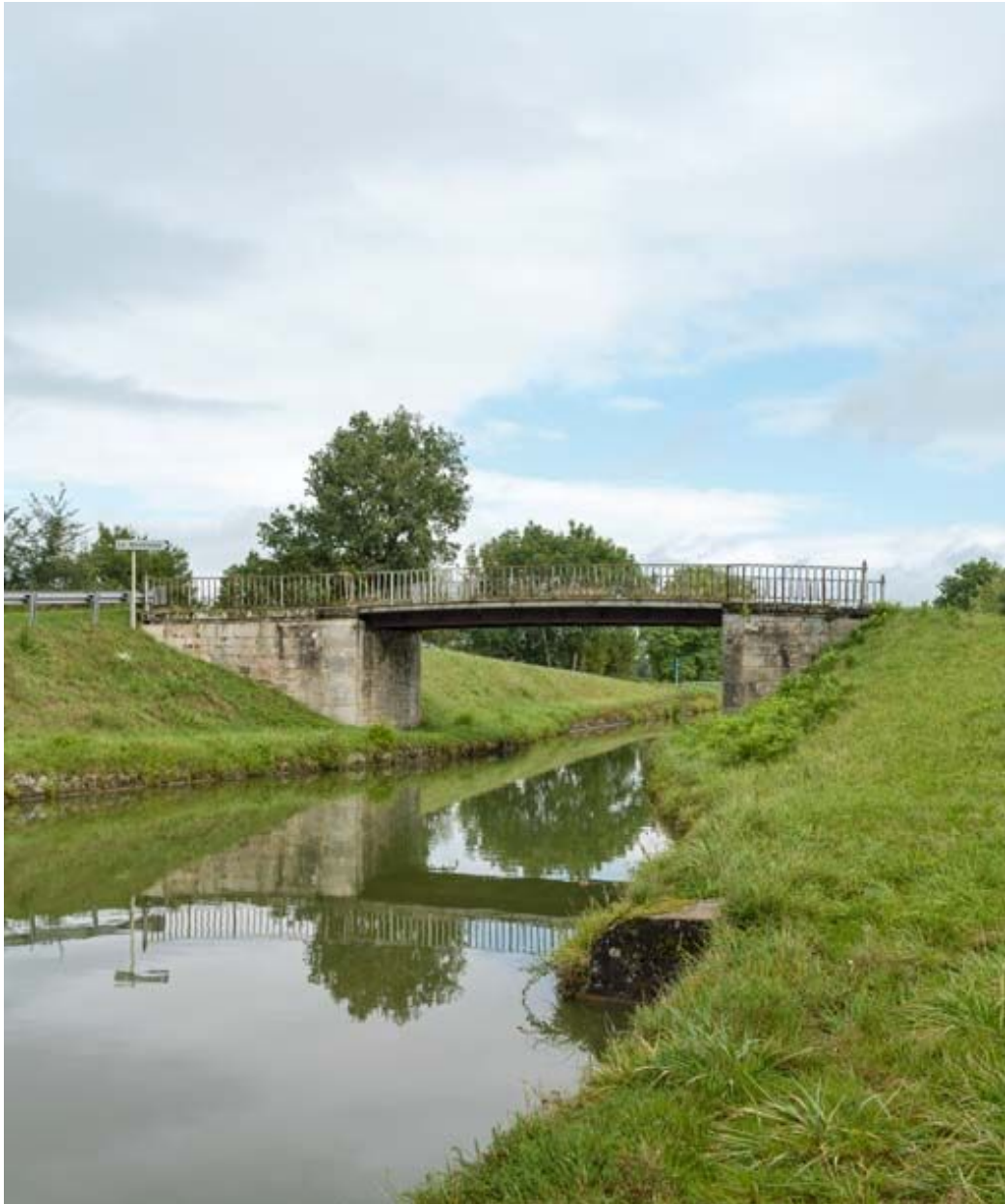
Vue d'ensemble du pont.
