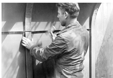
Montage d'un baraquement métallique dans les années 1940 : pose d'une agrafe. Phot. Jérôme Mongreville IVR43_19933900208X
