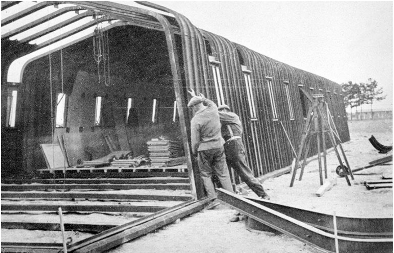
Montage d'un baraquement métallique dans les années 1940 : mise en place d'une tôle du mur.
