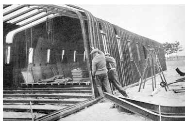
Montage d'un baraquement métallique dans les années 1940 : mise en place d'une tôle du mur. Phot. Jérôme Mongreville IVR43_19933900207X
