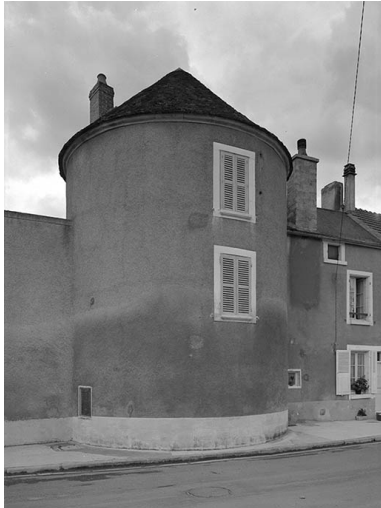
Façade sur rue. Phot. Jean-Luc Duthu IVR26_19748901244V
