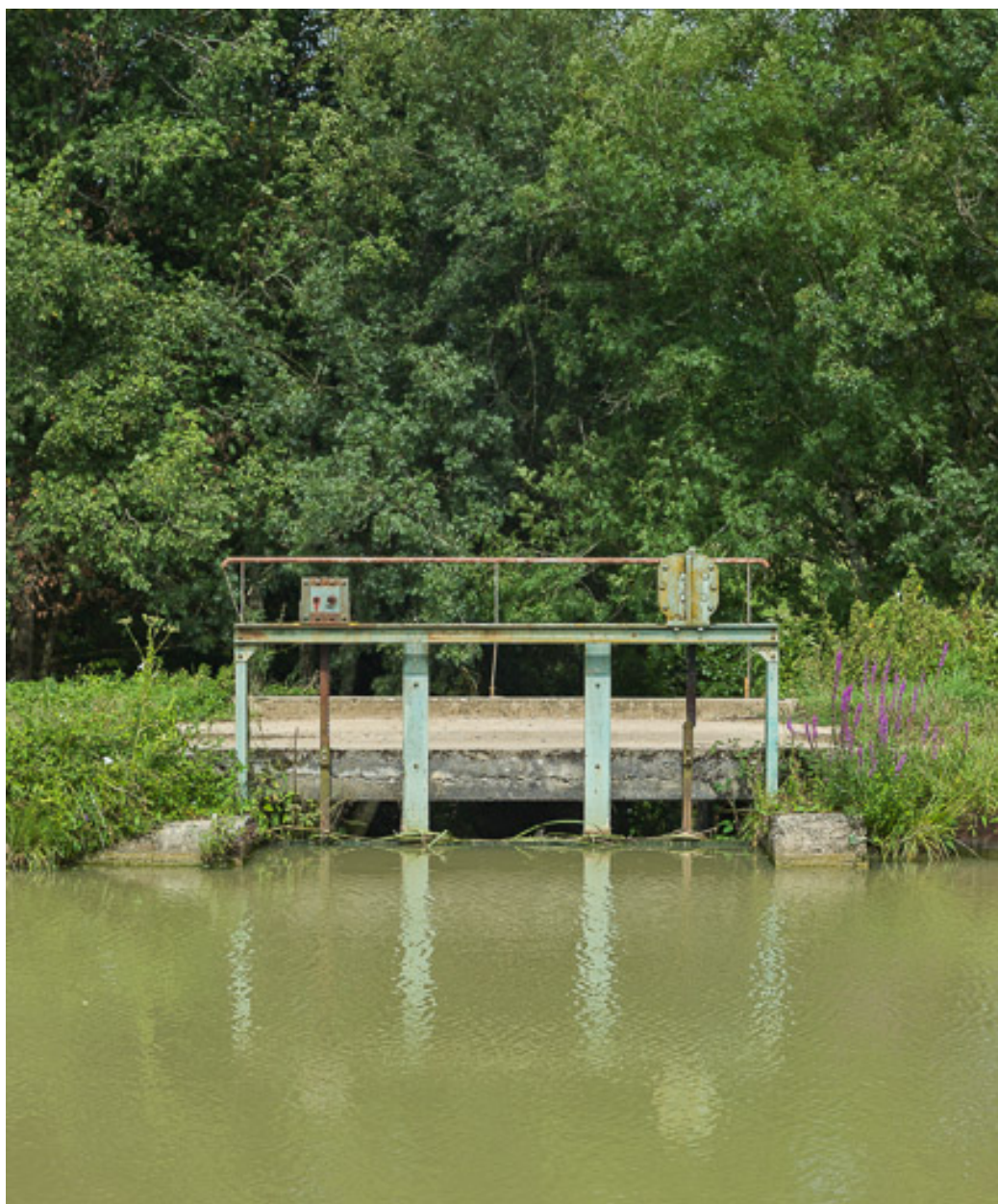
Vue du déversoir.
