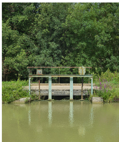
Vue du déversoir.
