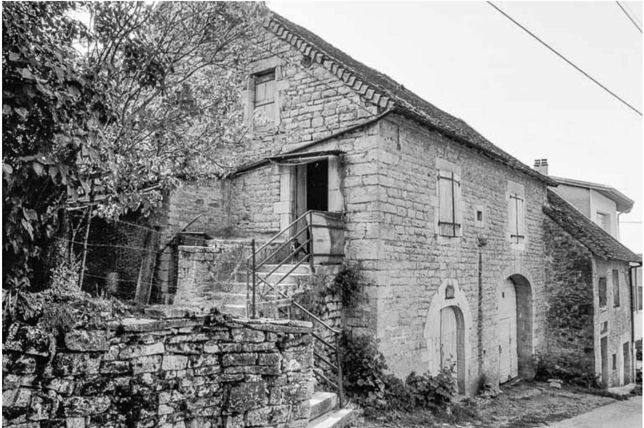
Façades antérieure et latérale gauche.
