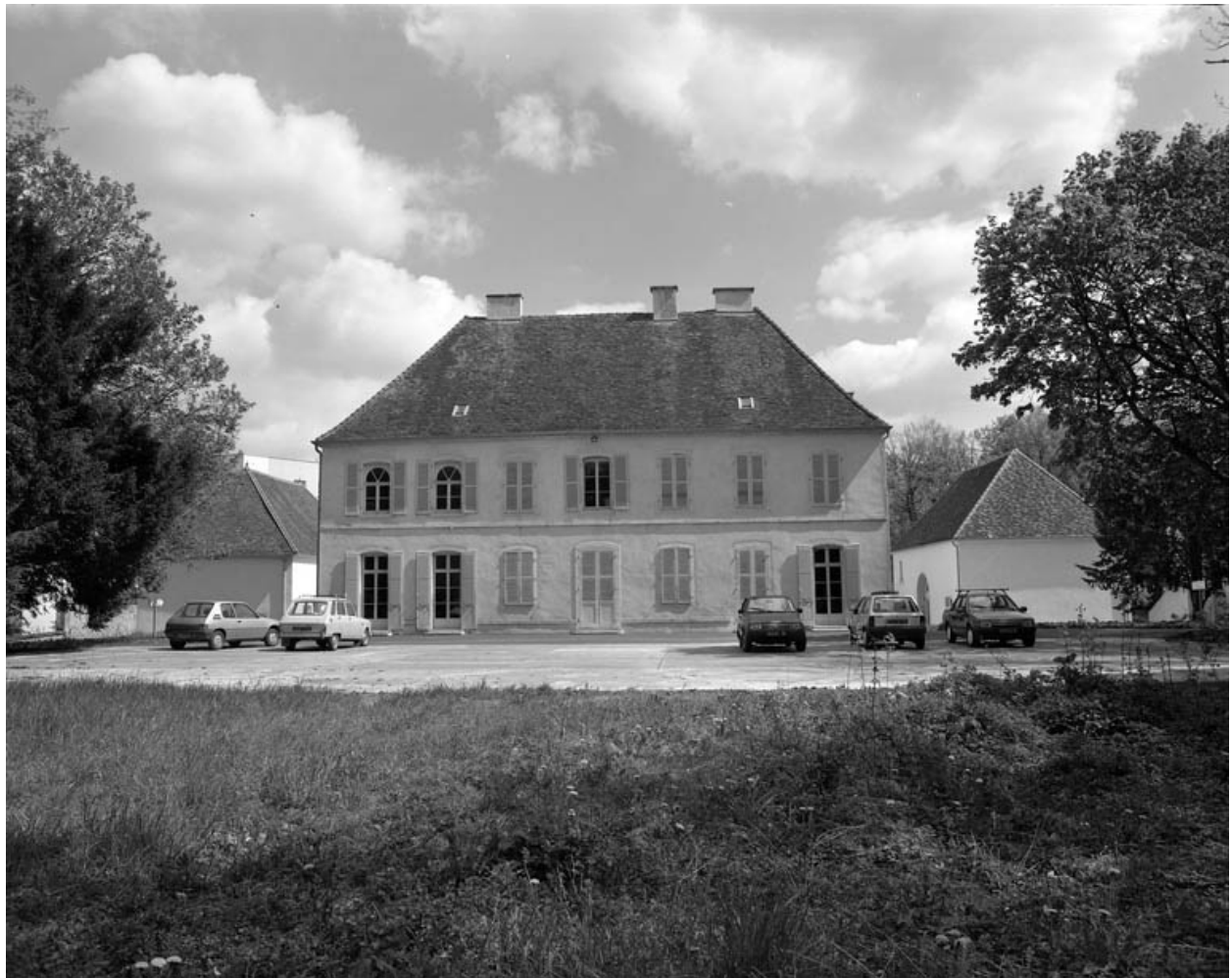
Façade postérieure depuis le parc.
