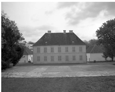
Façade postérieure, de face, depuis le parc. Phot. Yves Sancey IVR43_19917000246X
