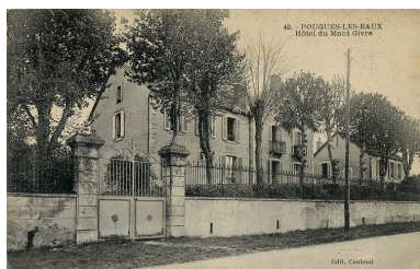
Vue ancienne. Autr. auteur inconnu IVR26_20205800362NUC4A
