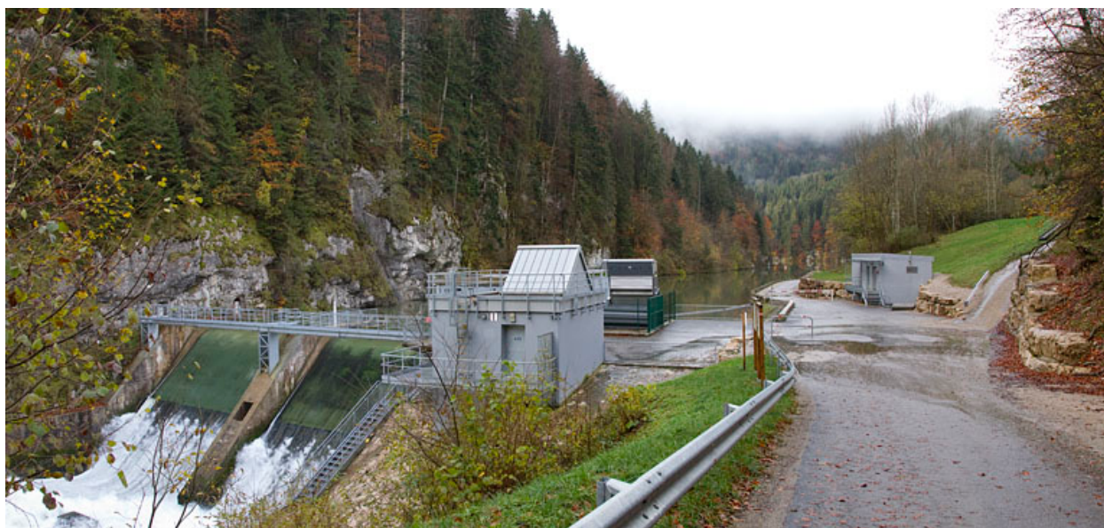
Barrage du Refrain : vue d'ensemble depuis l'aval.
