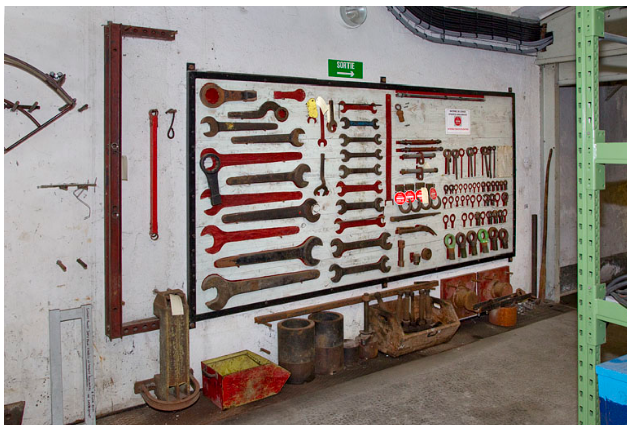
Centrale de Liebvillers : ratelier à clefs.
