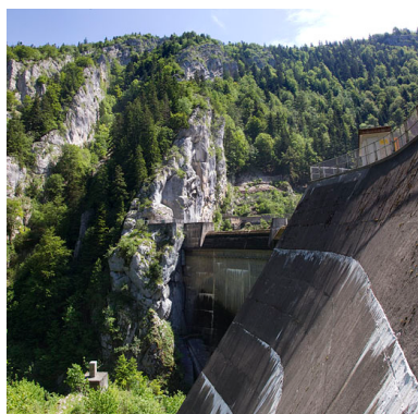
Barrage du Châtelot : ancrage rive droite. Phot. Yves Sancey IVR43_20130000012NUC2A
