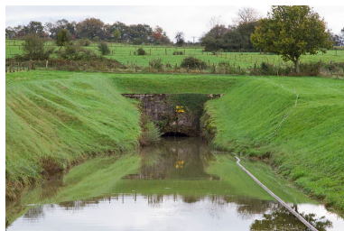
Centrale de la Prétière : extrémité du canal d'amenée souterrain. Phot. Yves Sancey IVR43_20122502055NUC2A
