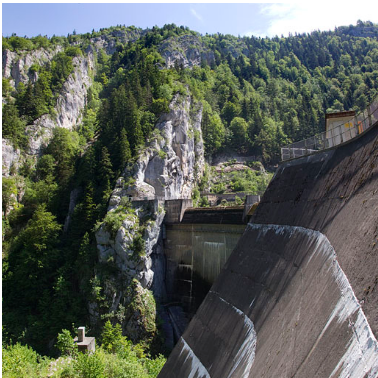
Barrage du Châtelot : ancrage rive droite.
