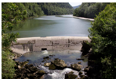
Barrage de la Goule : face aval.
