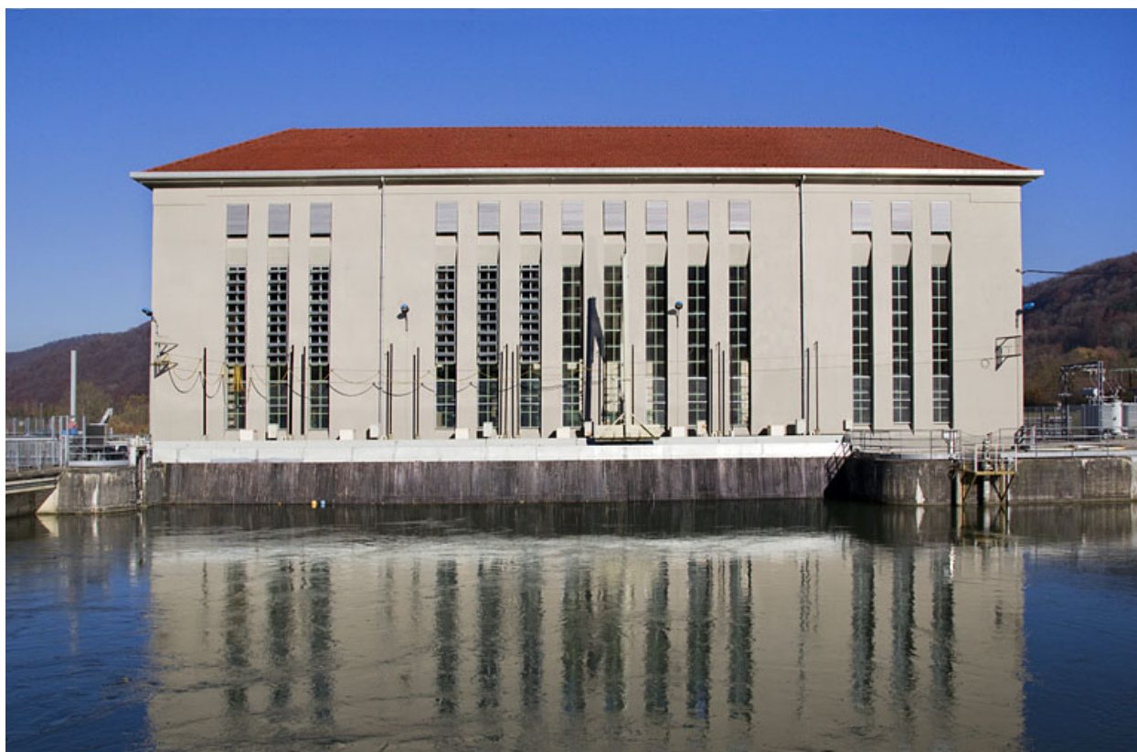
Centrale de Dampjoux : façade amont.
