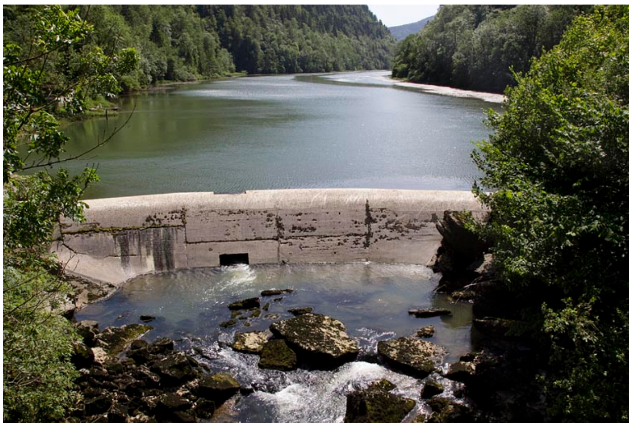
Barrage de la Goule : face aval.
