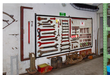
Centrale de Liebwillers : ratelier à clefs.
