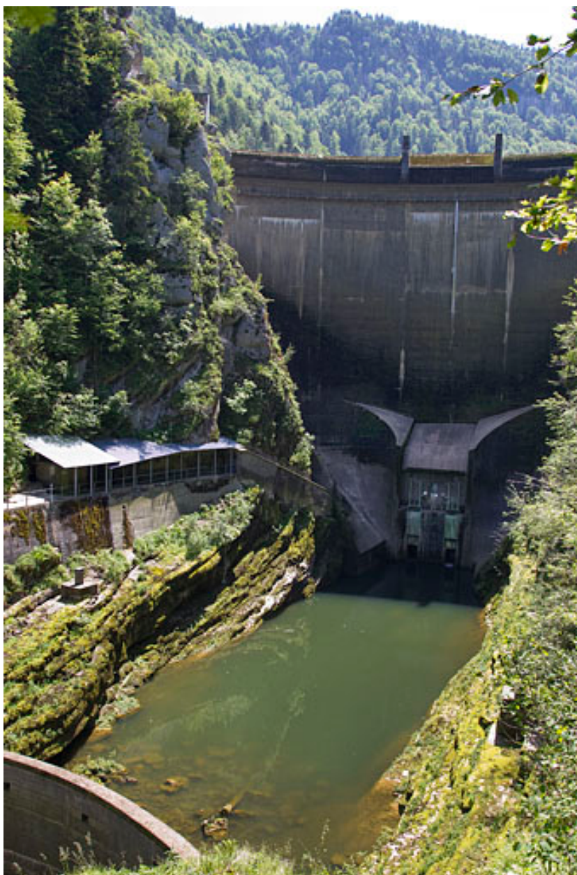
Barrage du Châtelot : le bassin d'amortissement.
