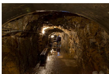
Centrale de Liebwillers : galerie d'accès à la conduite d'amenée souterraine.
