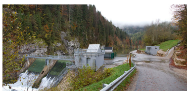
Barrage du Refrain : vue d'ensemble depuis l'aval.
