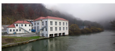
Centrale de Liebwillers : vue d'ensemble des bâtiments de production et du site de transformation.
