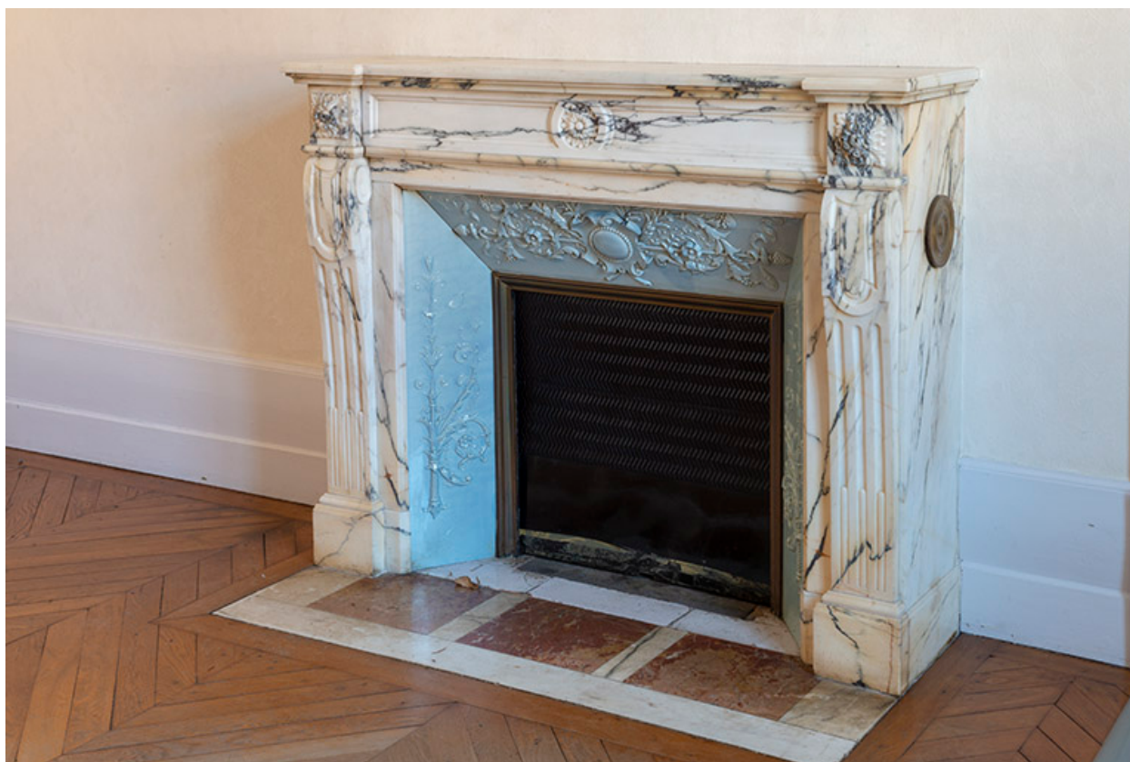
détail de la cheminée en marbre, rez-de-chaussée.
