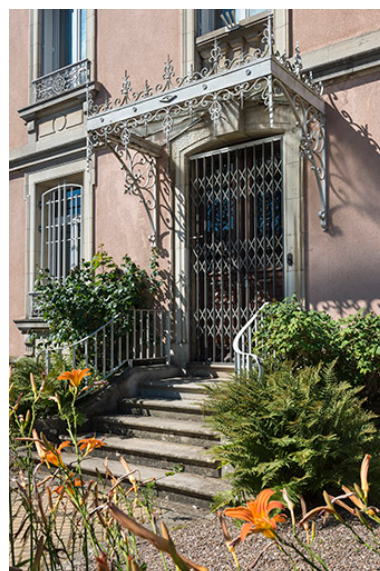
La porte d'entrée. Phot. Jérôme Mongreville IVR43_20187000382NUC4A
