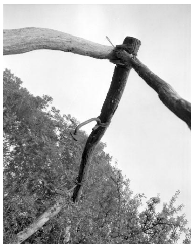
Détail des crochets retenant les câbles qui permettaient de descendre le lait jusqu'à la fromagerie. Phot. Jérôme Mongreville IVR43_19943901161X
