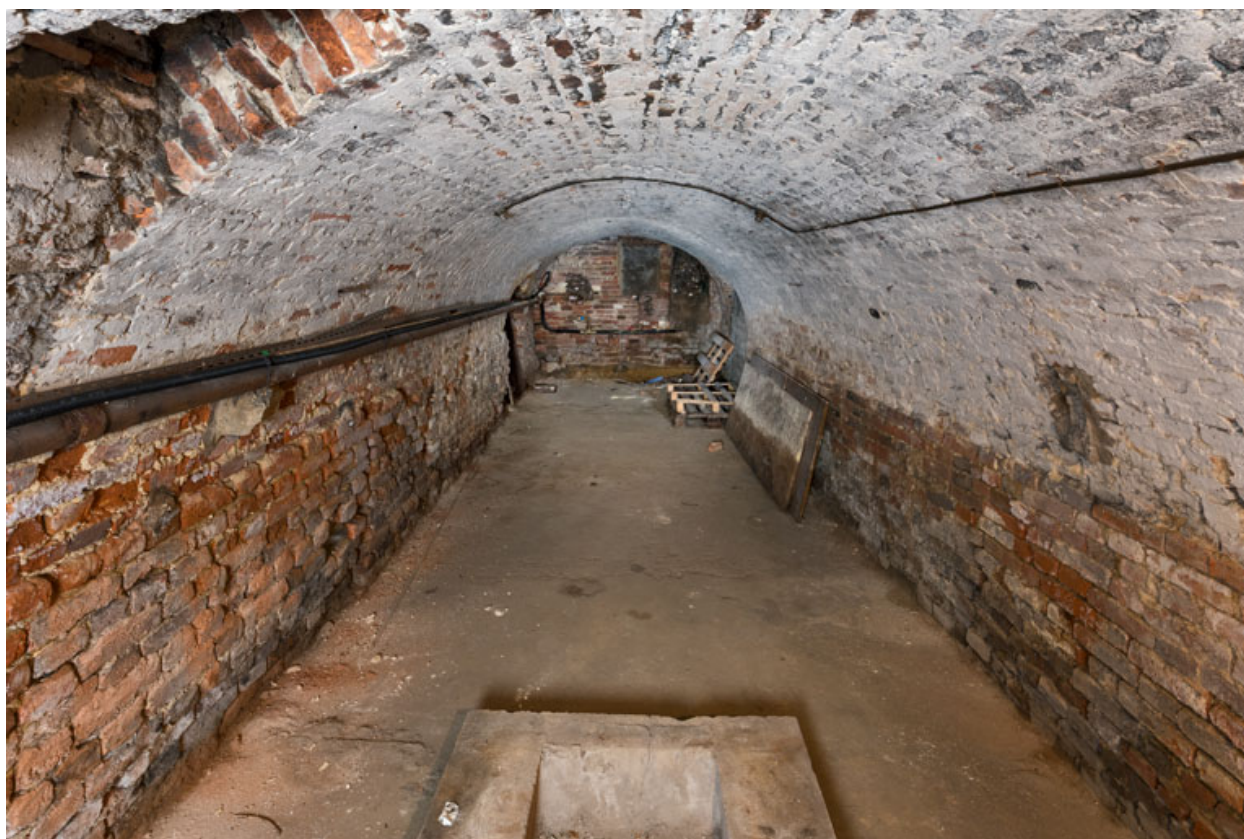
Cave voûtée au sous-sol.
