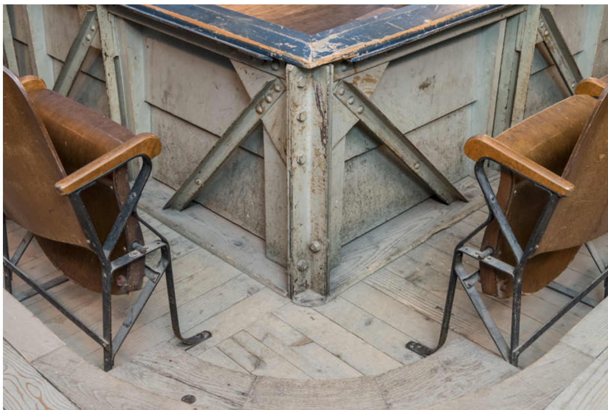
Balcon : structure métallique du garde-corps.
