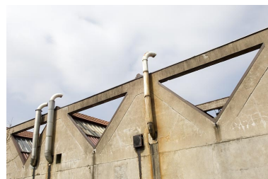
Pignons de l'atelier de fabrication.
