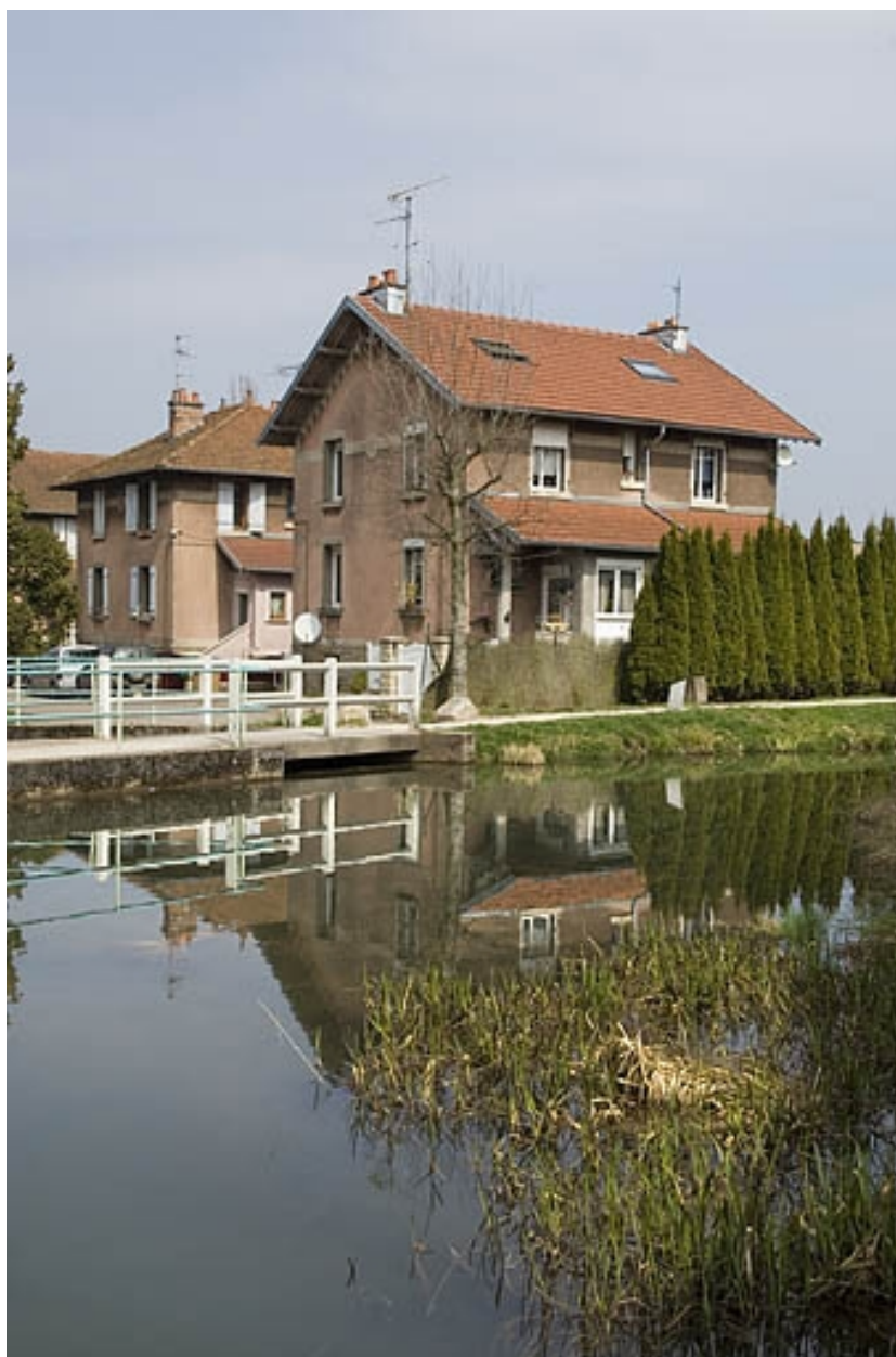
Logements ouvriers vus de trois quarts.
