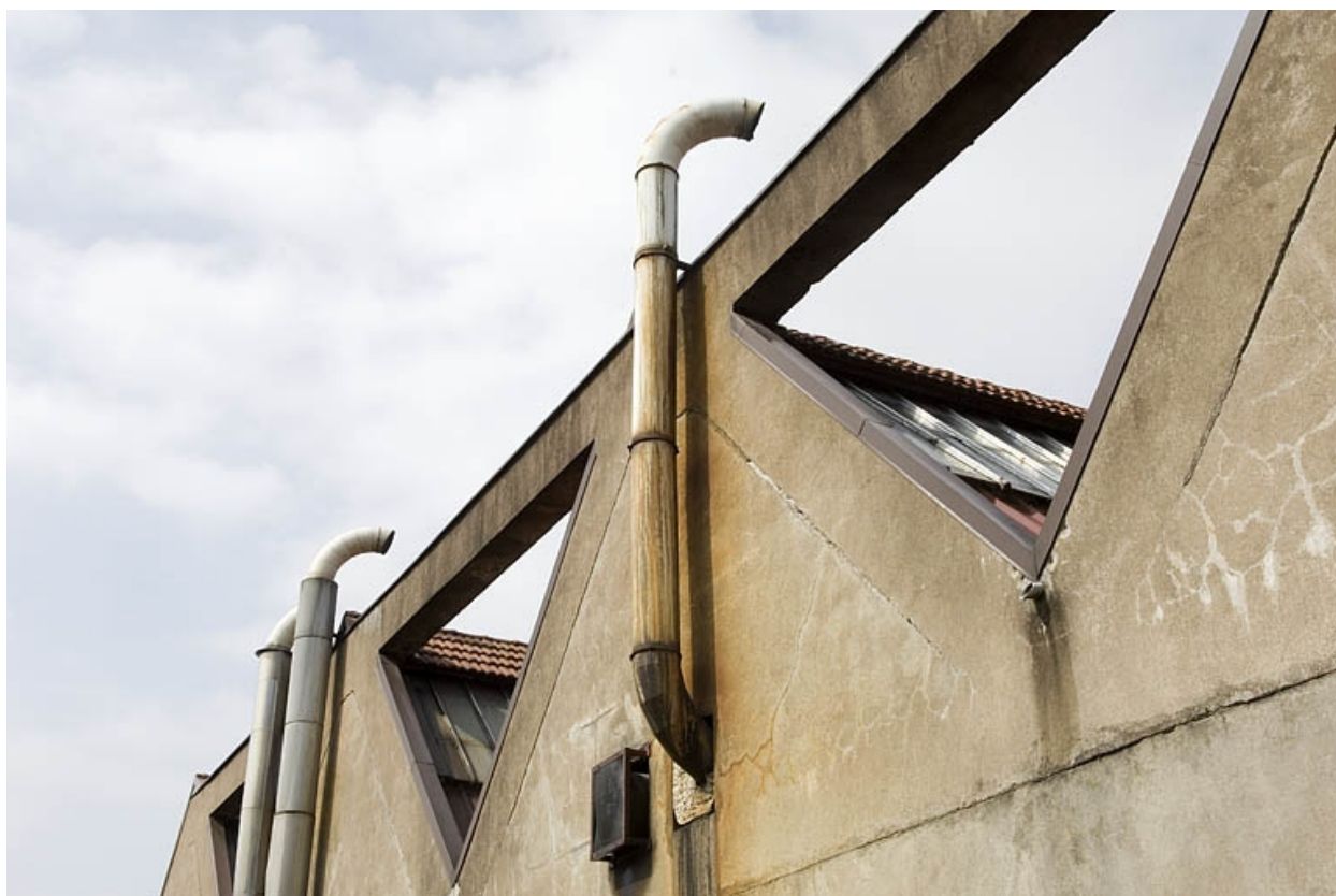
Pignons de l'atelier de fabrication. Détail.
