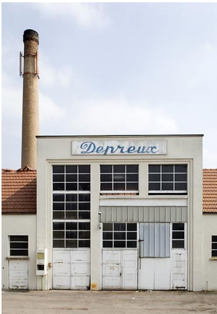
Cheminée et façade antérieure de l'ancienne chaufferie.
