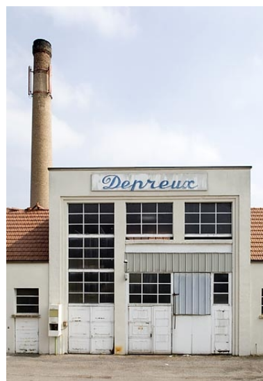
Cheminée et façade antérieure de l'ancienne chaufferie.
