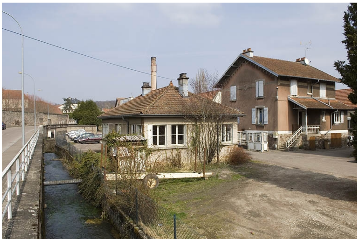
Conciergerie et logement ouvrier depuis le sud-ouest.
