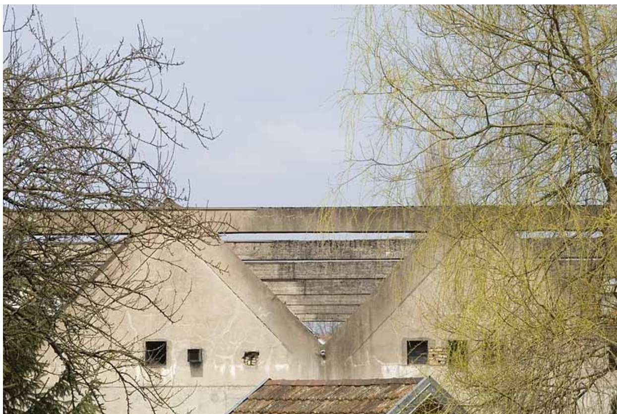
Pignons des toitures de l'atelier de fabrication.
