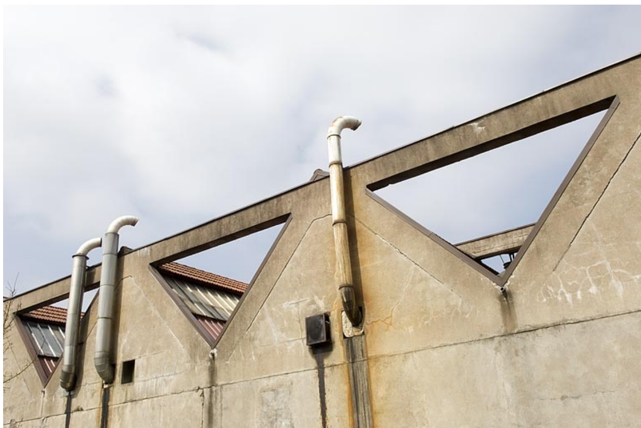
Pignons de l'atelier de fabrication.
