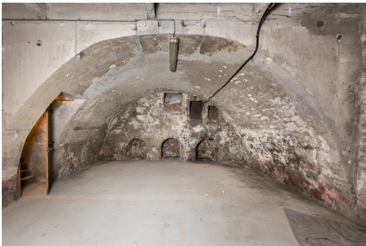
Caves nord : vue depuis l'est.
