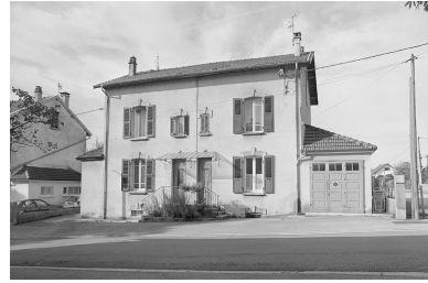
Façade antérieure. Phot. Jérôme Mongreville IVR43_19963901139X
