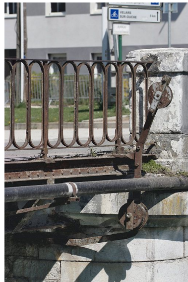
Détail du garde-corps et de la poulie. Phot. Thierry Kuntz IVR26_20112100035NUC2A
