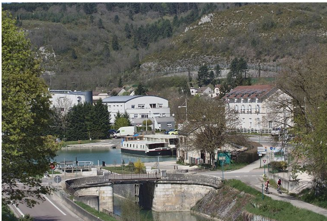
Vue d'ensemble du pont, vu de dessus.
