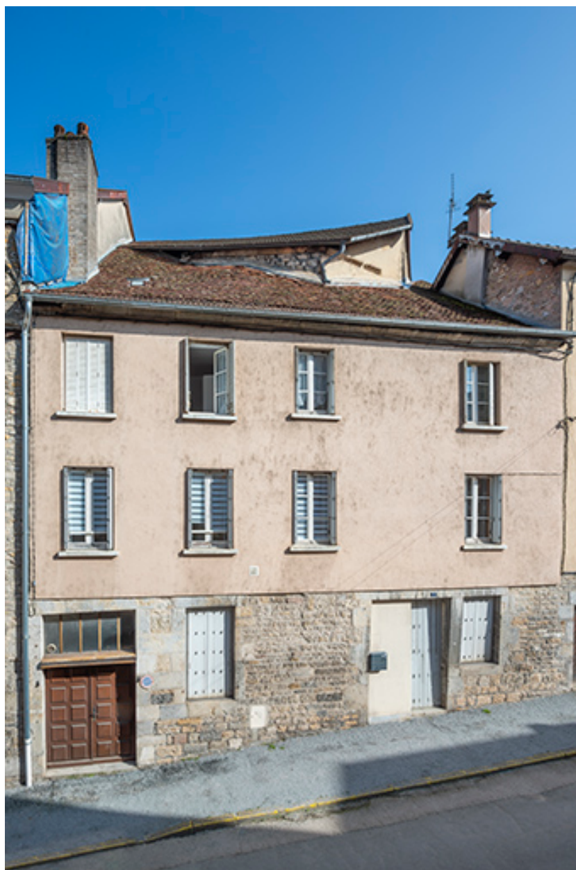
Façade ouest (rue Charles David).
