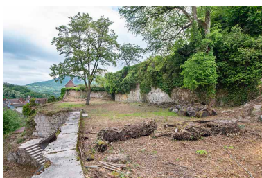
Terrasse maçonnée. Phot. Jérôme Mongreville IVR43_20233900436NUC4A
