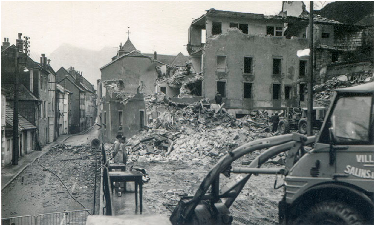
Démolition des bâtiments, vers 1973.
