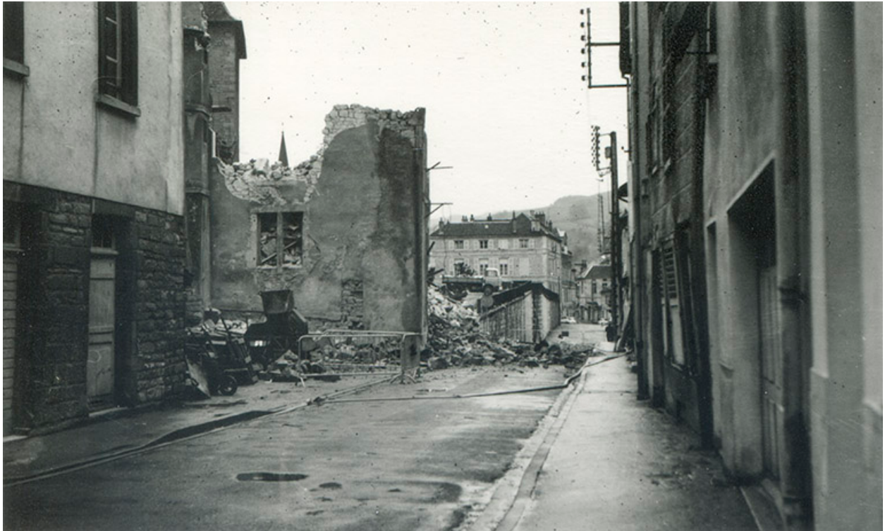
Démolition des bâtiments, vers 1973.
