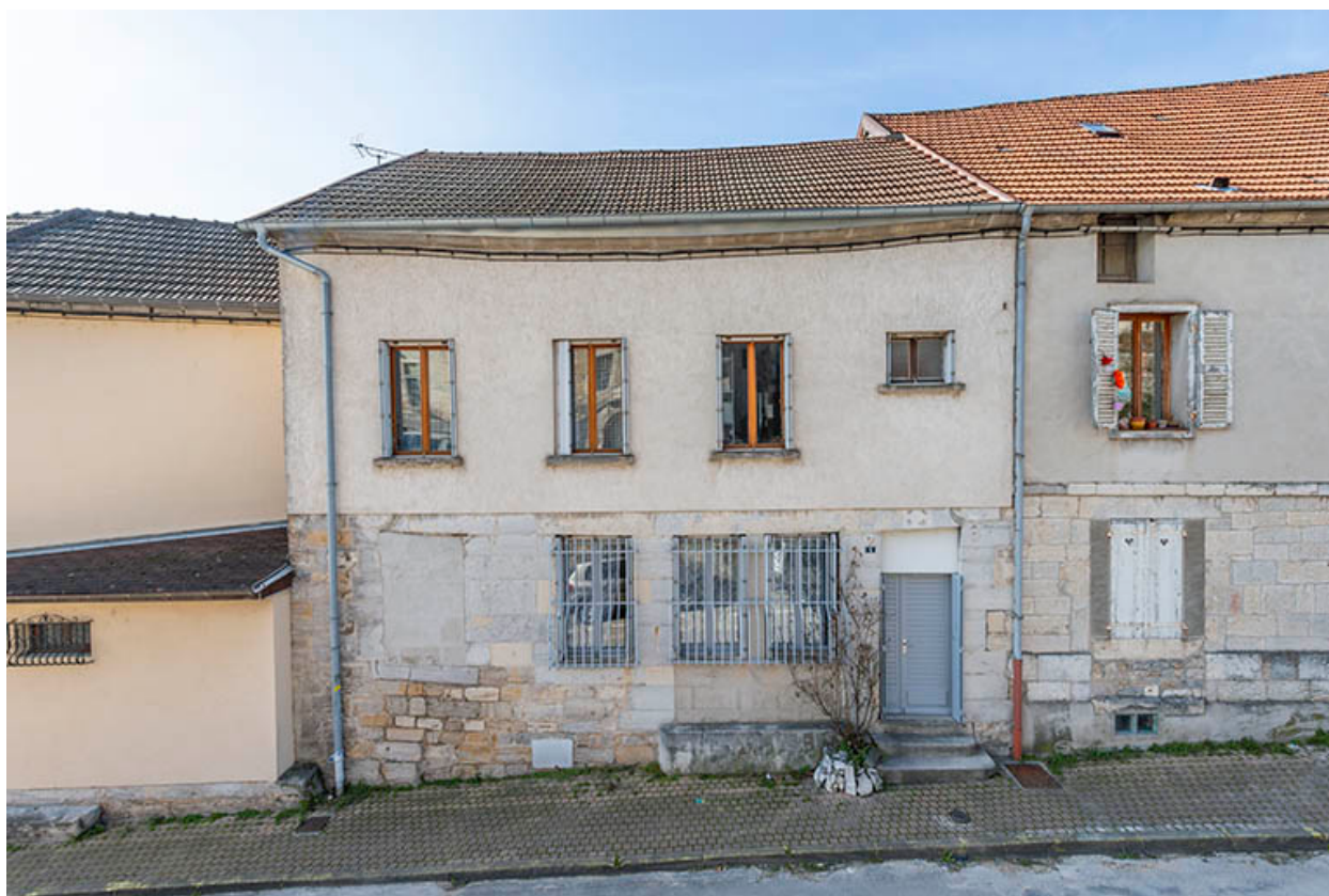
Façade est (rue Charles David).
