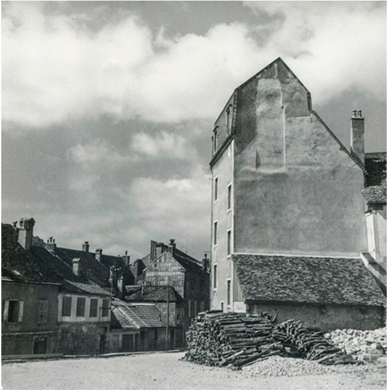
Elévation sud du bâtiment, s.d. [vers 1970].
