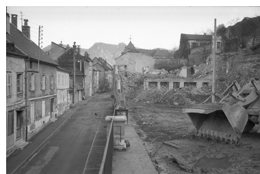
Démolition des bâtiments, vers 1973. Phot. Georges Chenu IVR43_20243900923NUC2A
