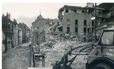
Démolition des bâtiments, vers 1973. Phot. Georges Chenu IVR43_20243900135NUC4A
