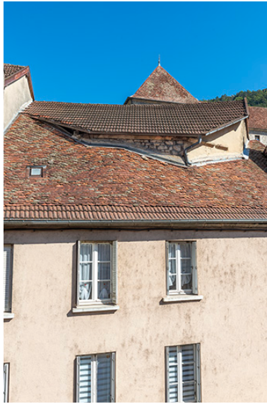
Versant ouest du toit. Phot. Jérôme Mongreville IVR43_20233900957NUC4A
