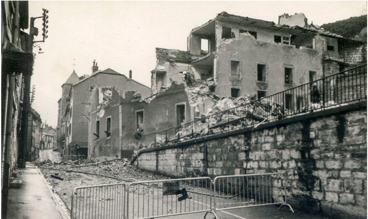
Démolition des bâtiments, vers 1973.
