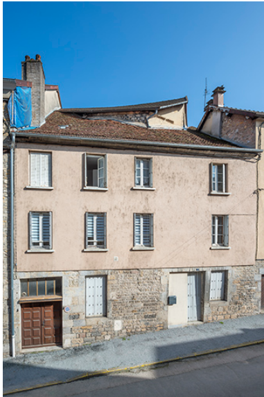
Façade ouest (rue Charles David). Phot. Jérôme Mongreville IVR43_20243900578NUC4A
