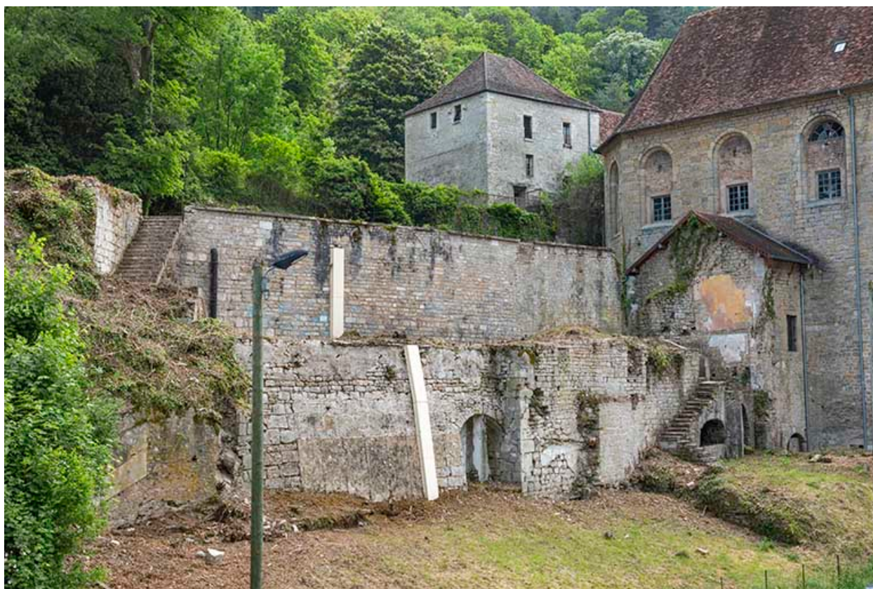
Terrasses maçonnées (emplacement des bâtiments).
