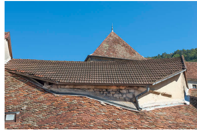
Chevet polygonal émergeant du versant ouest. Phot. Jérôme Mongreville IVR43_20233900958NUC4A
