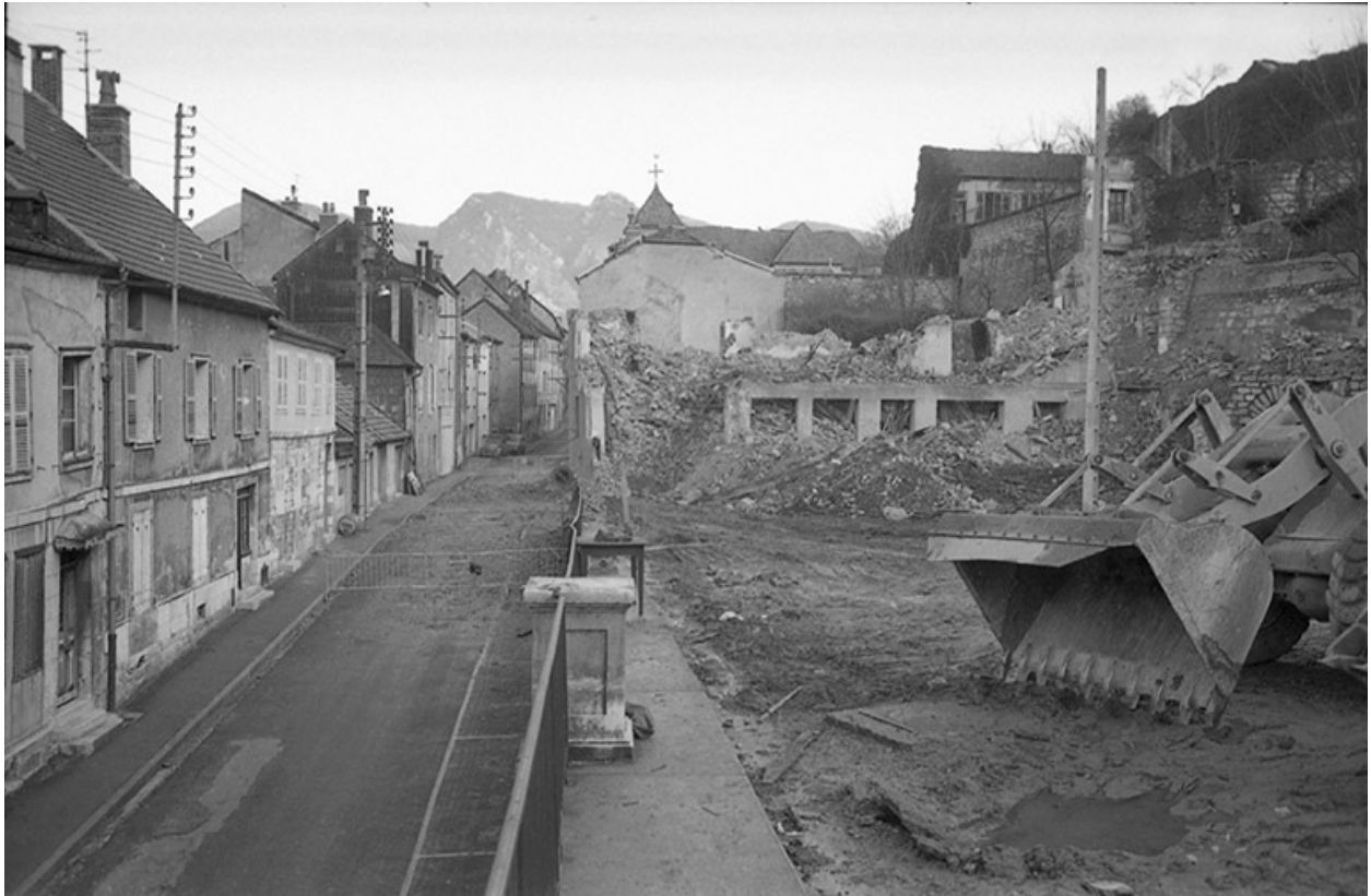
Démolition des bâtiments, vers 1973.
