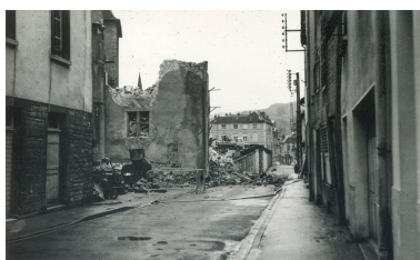
Démolition des bâtiments, vers 1973. Phot. Georges Chenu IVR43_20243900136NUC4A
