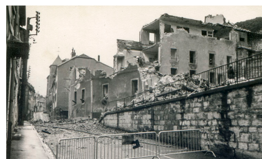
Démolition des bâtiments, vers 1973. Phot. Georges Chenu IVR43_20243900134NUC4A
