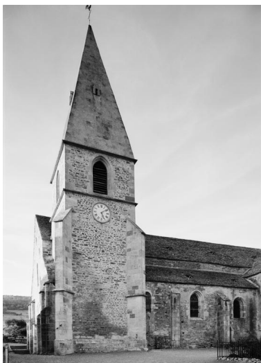
Elévation droite du clocher et de la nef. Phot. Michel Rosso IVR26_19782101419V
