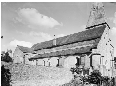
Elévation latérale gauche, vue prise de 3/4 droit.
