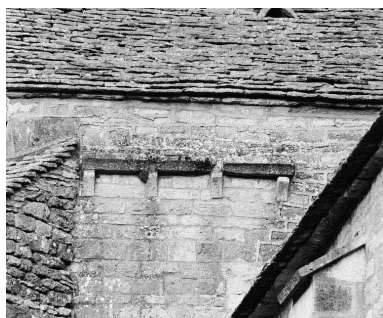
Détail du mur antérieur de la chapelle gauche. Phot. Jean-Luc Duthu IVR26_19782101431X
