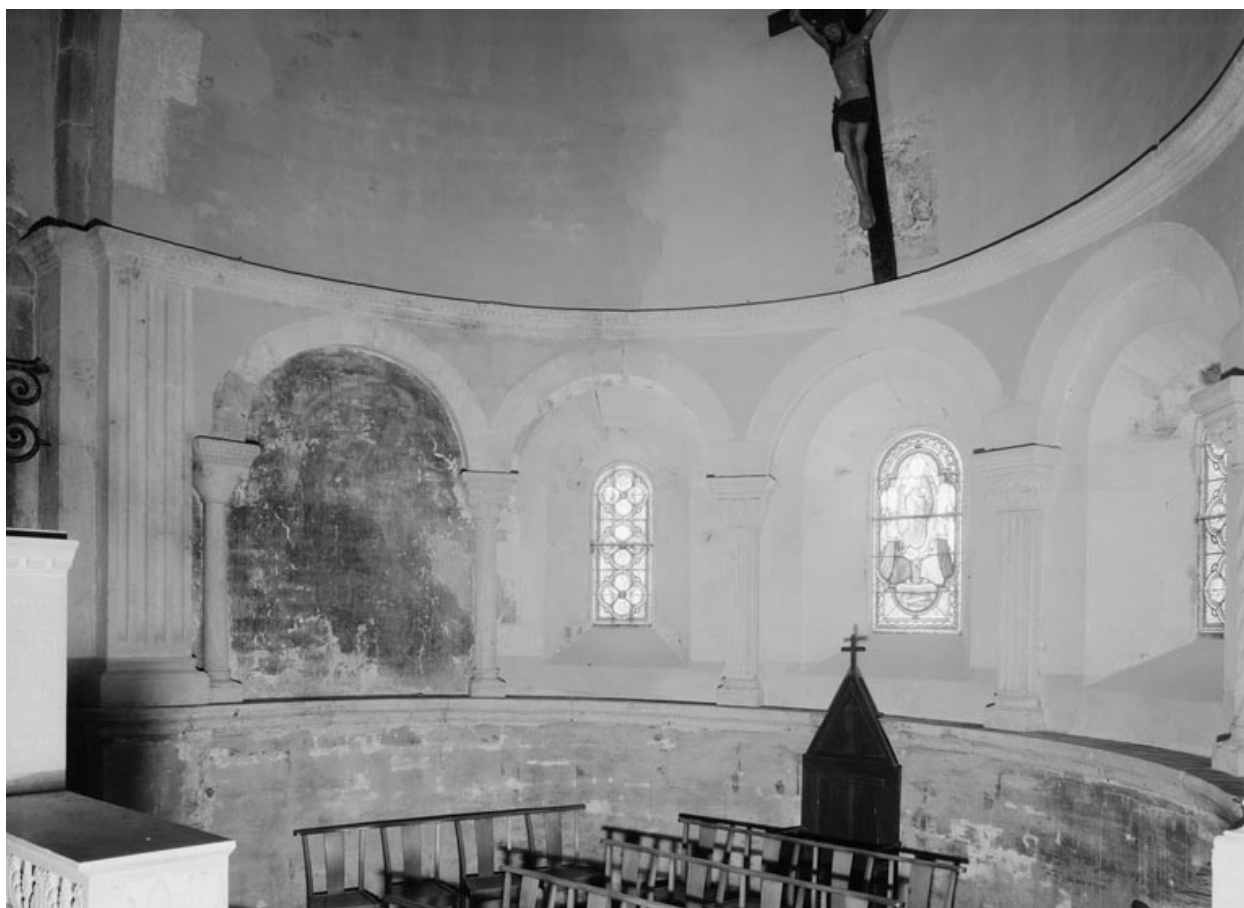
Choeur : détail de l'abside.
