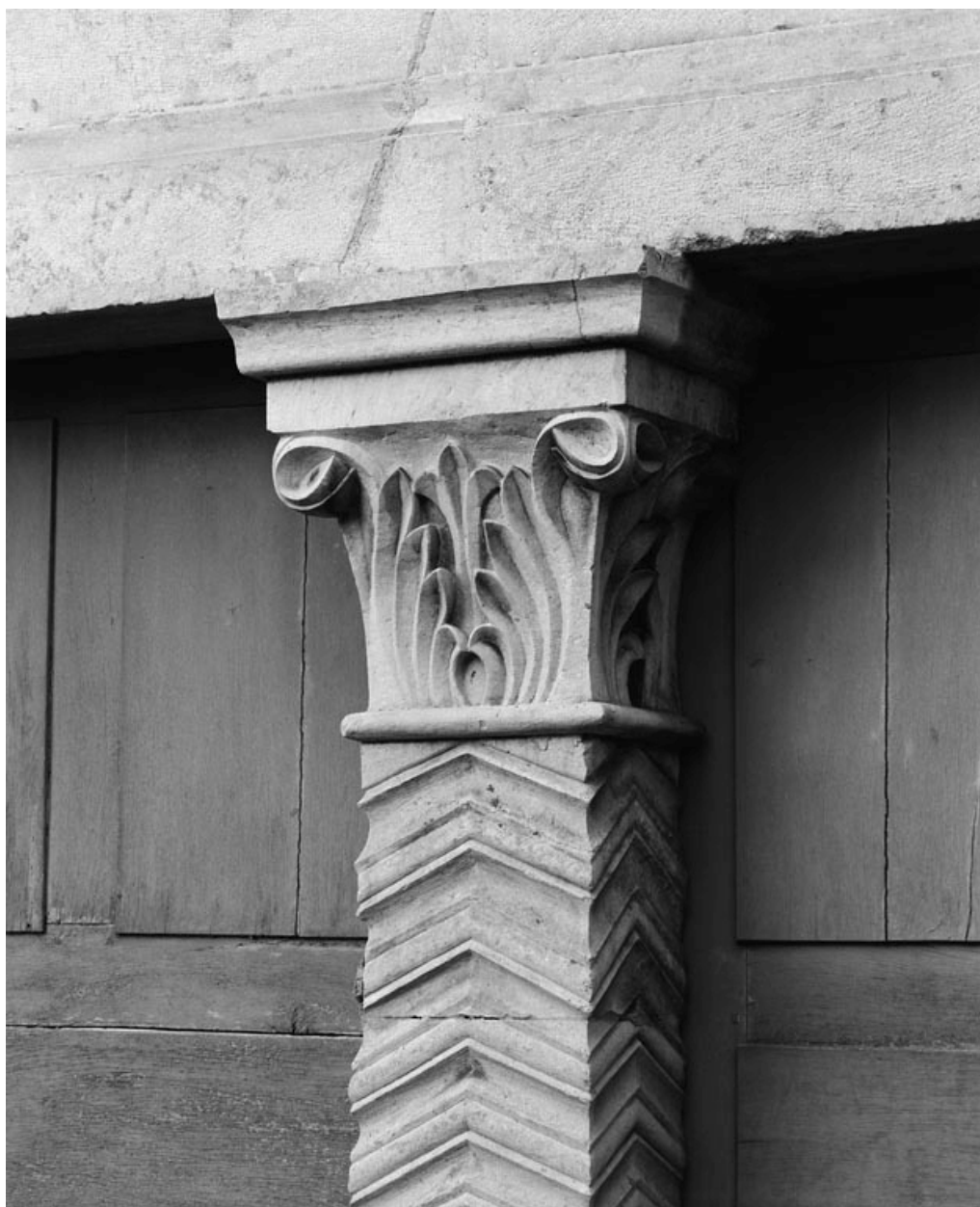
Détail du pilier central du portail.
