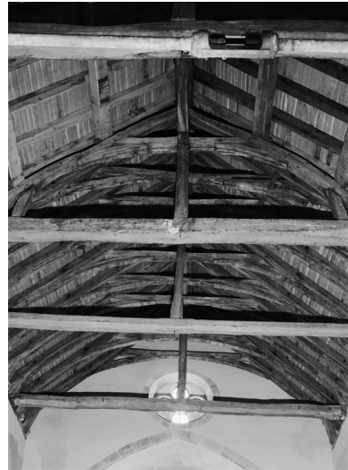
Charpente de la nef : détail. Phot. Michel Thierry IVR26_19802100494V
