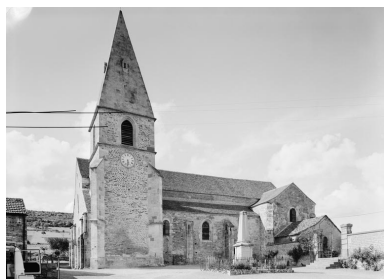
Elévation latérale droite. Phot. Michel Rosso IVR26_19802100688V
