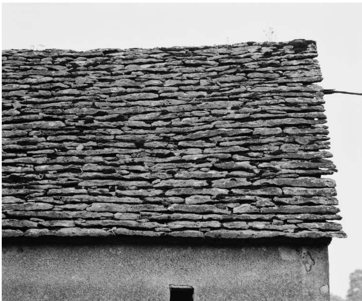
Détail du toit de la sacrisitie.
