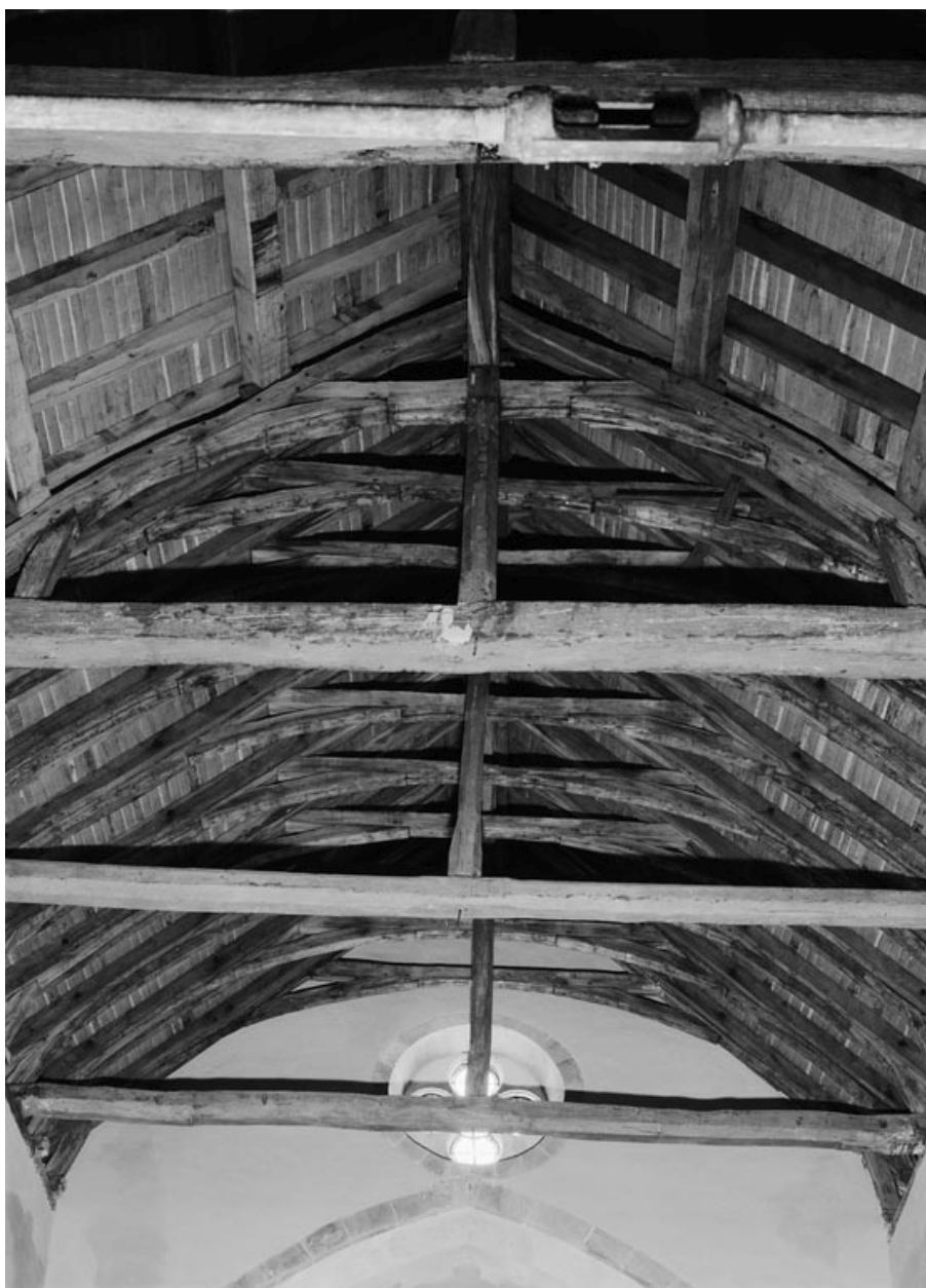
Charpente de la nef : détail.
