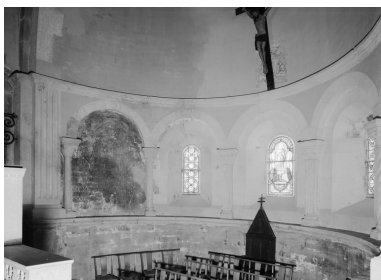
Choeur : détail de l'abside. Phot. Michel Thierry IVR26_19802100500V
