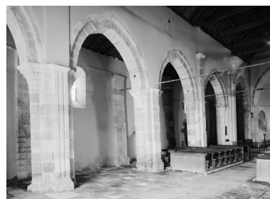
Nef et bas-côté gauche. Phot. Michel Thierry IVR26_19802100490V
