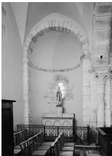
Chapelle gauche. Phot. Michel Thierry IVR26_19802100496V
