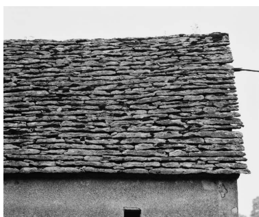
Détail du toit de la sacristie. Phot. Jean-Luc Duthu IVR26_19782101430X
