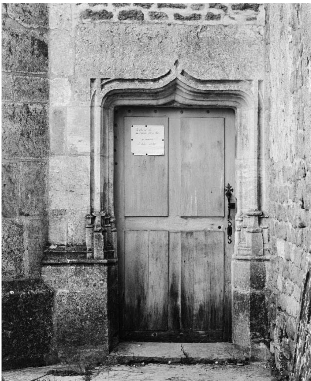
Détail de la porte de la face postérieure du clocher.
