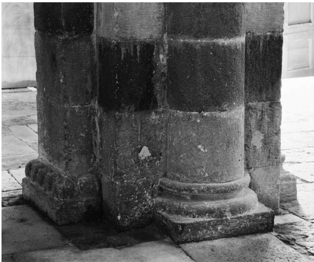
Détail de la base du pilier antérieur droit de la nef.
