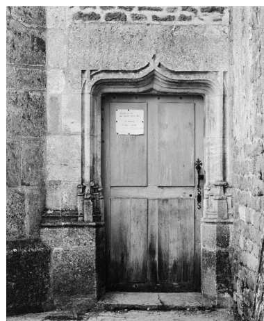
Détail de la porte de la face postérieure du clocher. Phot. Jean-Luc Duthu IVR26_19782101424X
