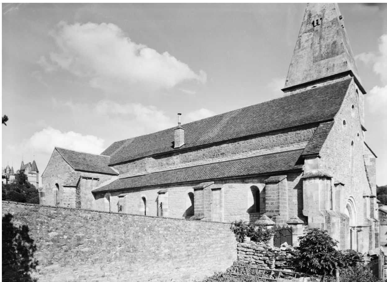
Elévation latérale gauche, vue prise de 3/4 droit.
