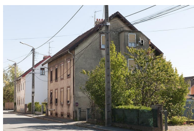
Vue de trois quarts de deux habitations. Phot. Jérôme Mongreville IVR43_20112502383NUC4A
