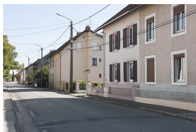
Façades antérieures sur la rue des Mines. Phot. Jérôme Mongreville IVR43_20112502382NUC4A
