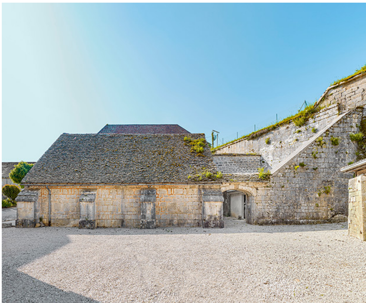
Vue latérale nord.
