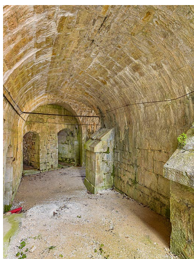
Une partie du couloir entourant l'édifice. Phot. Thierry Kuntz IVR43_20233900610NUC4A
