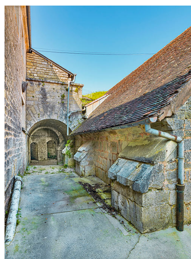
Les contreforts épaulant la poudrière. Phot. Thierry Kuntz IVR43_20233900609NUC4A
