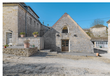
Vue générale. Phot. Thierry Kuntz IVR43_20223900543NUC4A
