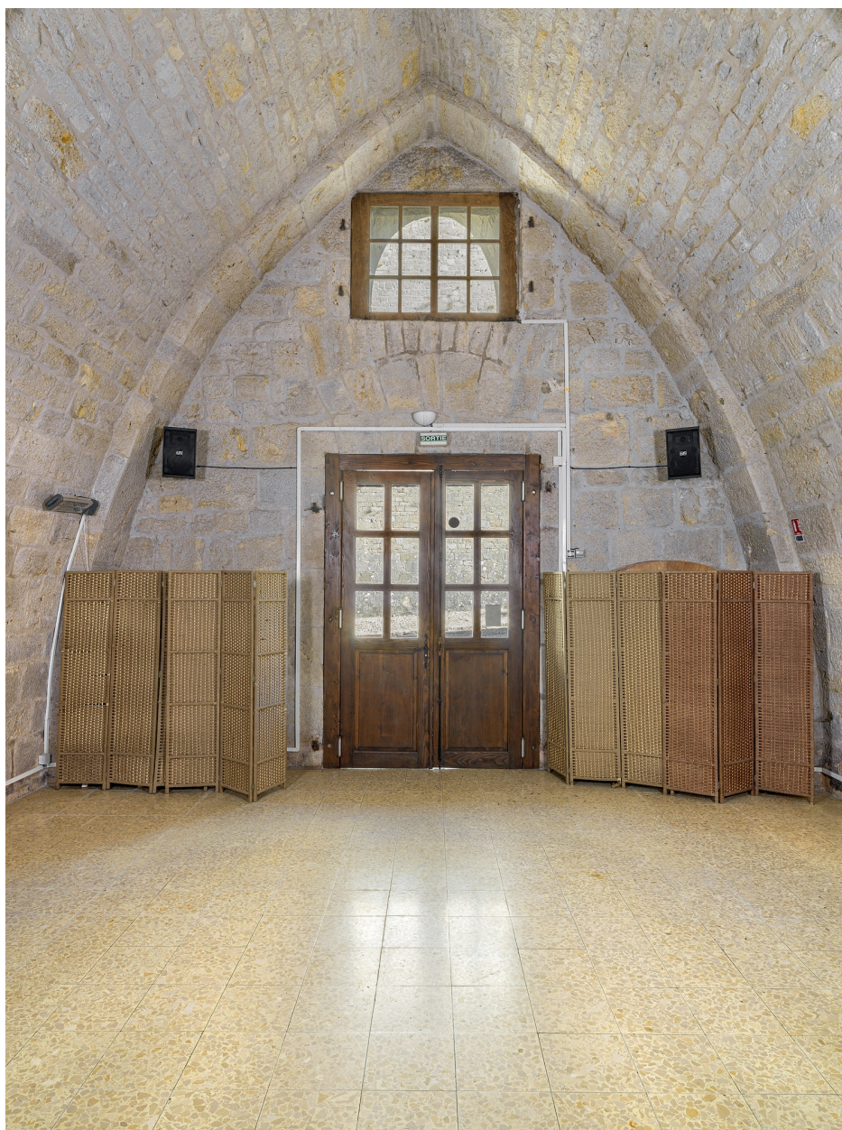
Vue intérieure depuis le mur postérieur.
