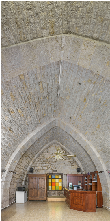
La voûte en berceau brisé. Phot. Thierry Kuntz IVR43_20213900353NUC4A
