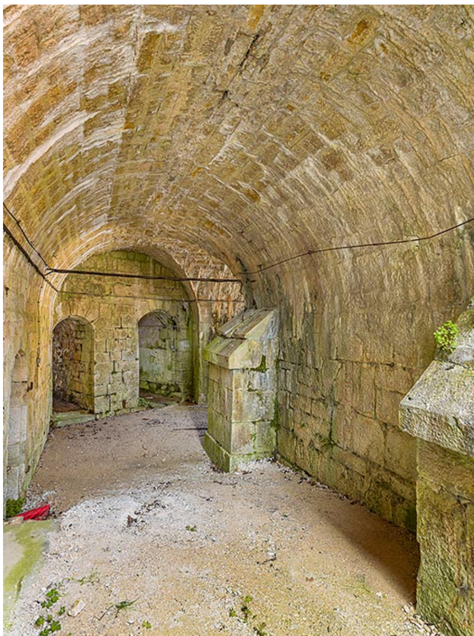
Une partie du couloir entourant l'édifice.
