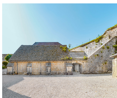
Vue latérale nord. Phot. Thierry Kuntz IVR43_20233900607NUC4A
