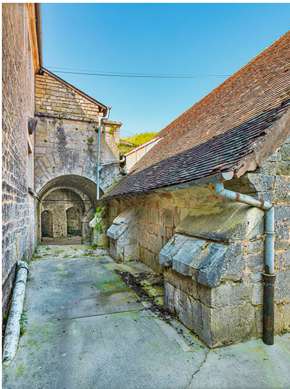
Les contreforts épaulant la poudrière.
