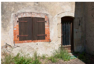
Ouverture remaniée. Phot. Jérôme Mongreville IVR43_20177000424NUC4A
