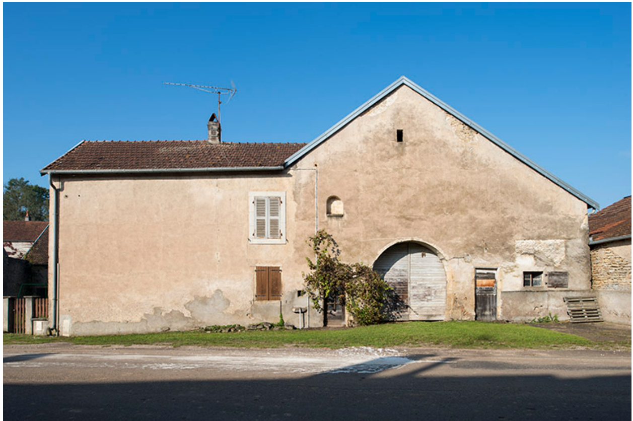
La ferme, "côté rue".
