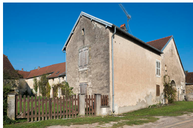
Vue générale depuis la Grande rue. Phot. Jérôme Mongreville IVR43_20167001607NUC4A
